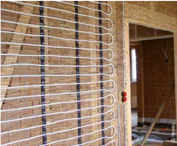
Wandheizung auf Schilfrohmatten
