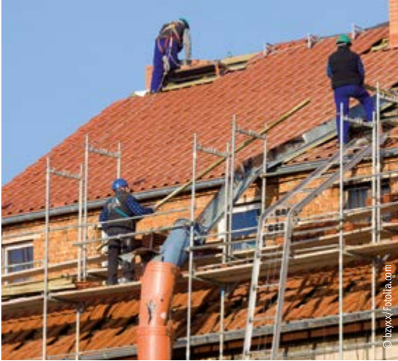
Dacheindeckung mit naturroten Falzziegeln
