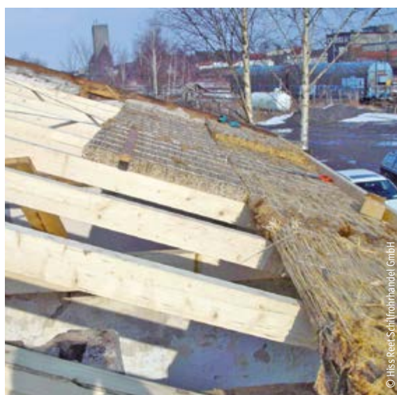
Aufdachdämmung mit Schilfrohrdämmplatten
