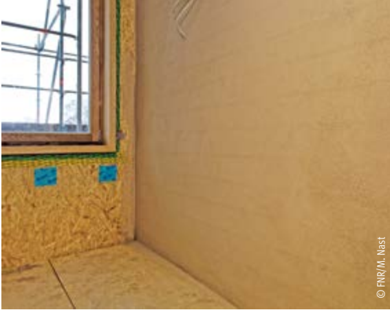
Lehmputz auf Mauerwerk
