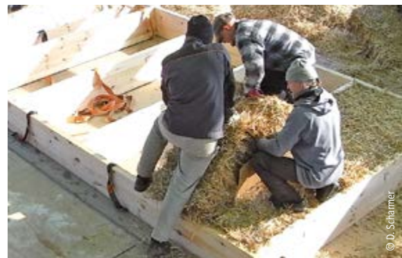
Ausfächung von vorgefertigten Holzbauelementen mit Strohballen ab einer Dicke von 40 cm
