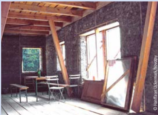
Hanfämmlehm als Innendämmung der Außenwand
