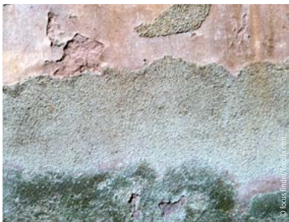
Schadhafte Putzoberfläche
