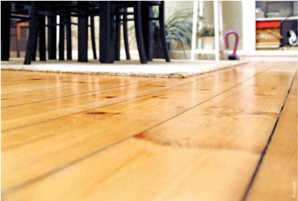
Gut erhaltener und gepflegter Holzdielenboden: Fugenbildung und Ergänzungen gehören zu einem in Würde gealterten Dielenboden.
