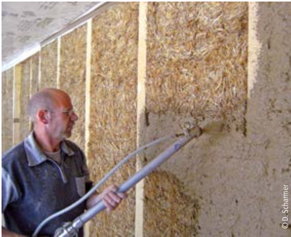
Aufbringen des Lehmputzes mittels Putzmaschine
