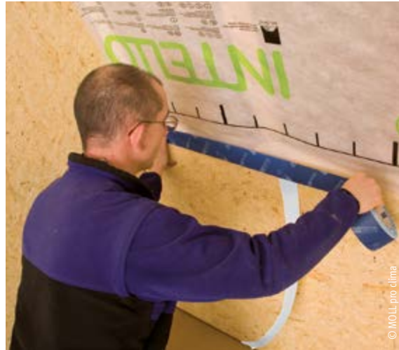
Anschluss an Drempelwand
