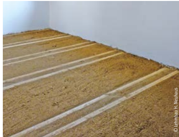
Hohlraumfüllung mit Lehm-Trockenschüttung
