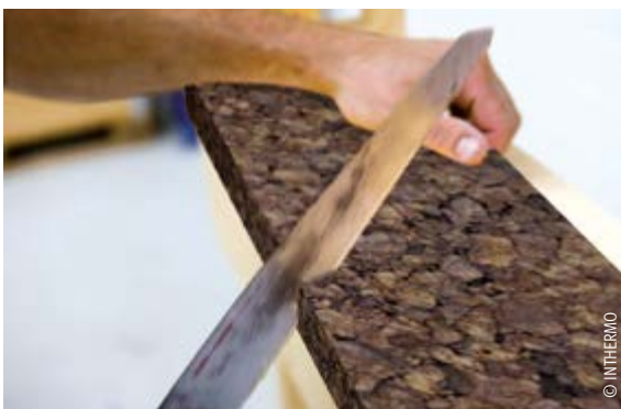
Einfacher Zuschnitt von Korkdämmplatten
