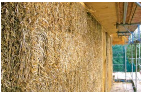
Stroh zwischen einer Holzrahmenkonstruktion (außen)
