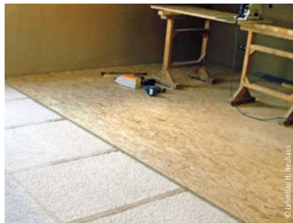
Hohlraumfüllung mit Perlite, Abdeckung mit OSB-Platten
