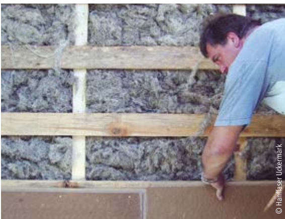
Innendämmung mit Hanfstopfwolle und verputzbarer Holzfaserplatte
