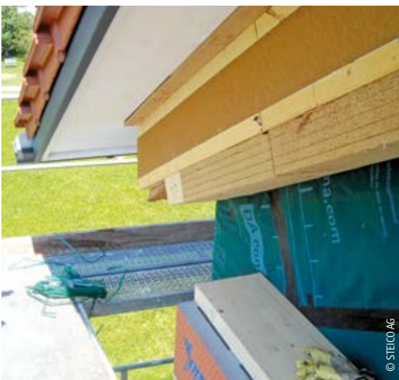
Detail einer Dachdeckung mit Holzfaserdämmung
