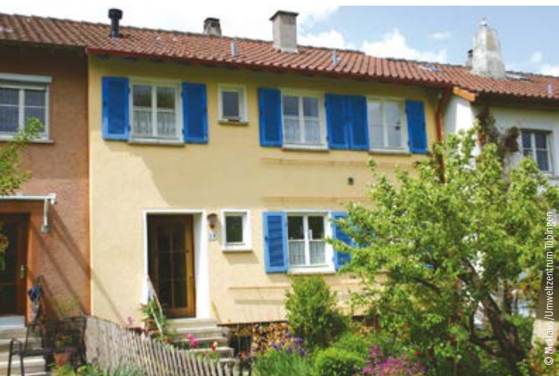
Reihenhaus in Tübingen, gedämmt mit verputzter Vorhangfassade und 16 cm Zellulose-Einblasdämmung. Beplankung mit Holz- wolle-Leichtbauplatten.
