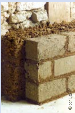
Wegen Reduzierung des Fugenanteils großformatige Steine bevorzugen.
