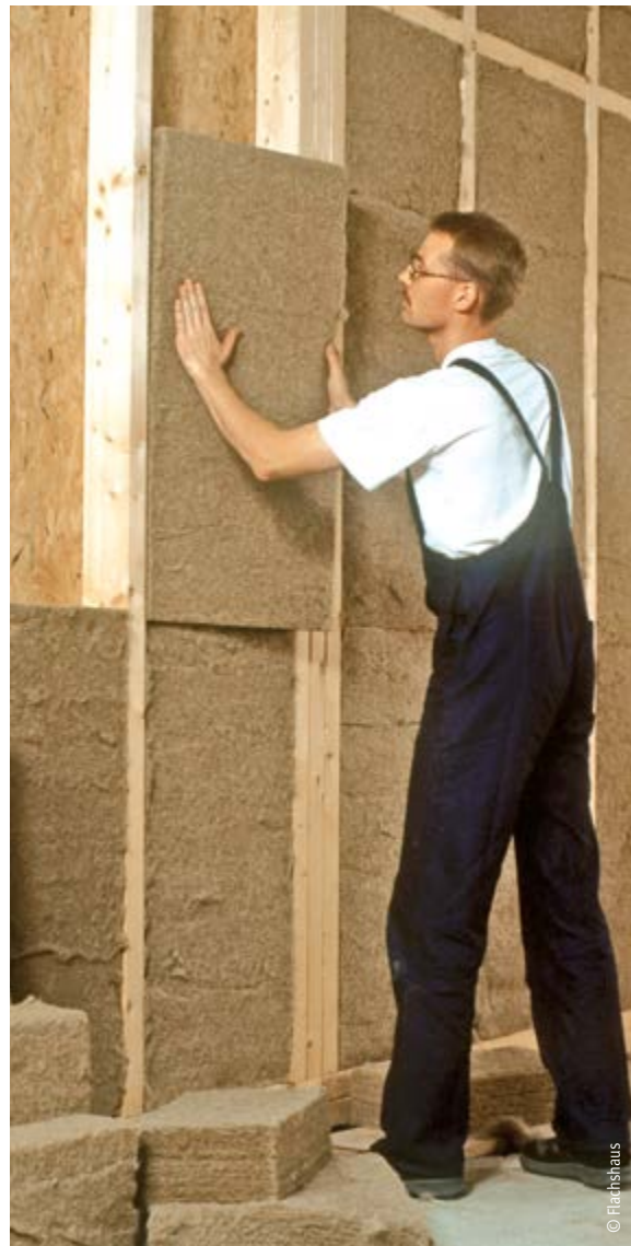
Ausfachung von Ständerwerk mit Flachsmatten
