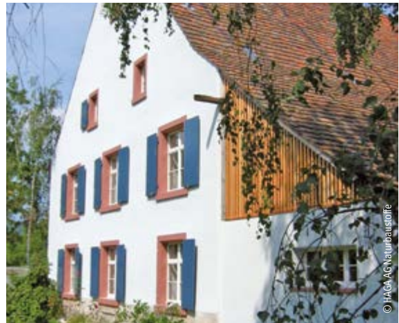
Nicht leicht unter ein Dach zu bringen: Zeitgemäßes Wohnen unter Wahrung der baugeschichtlichen Vorgaben mit Berücksichtigung von notwendigen Energiesparmaßnahmen
