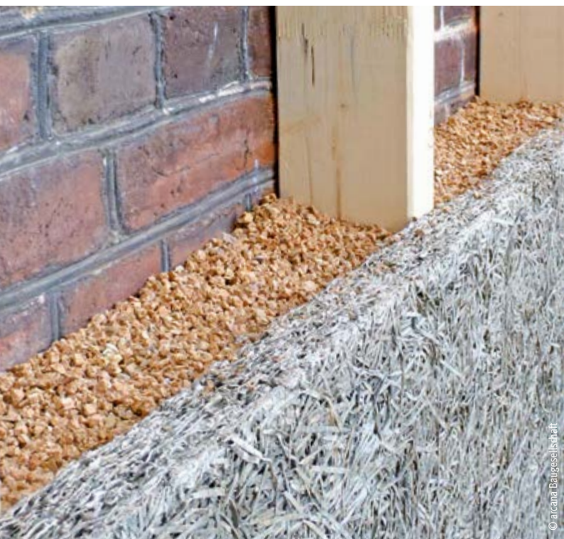
Außenwanddämmung: Korkschüttung mit Holzwolle-Dämmplatten auf Unterkonstruktion
