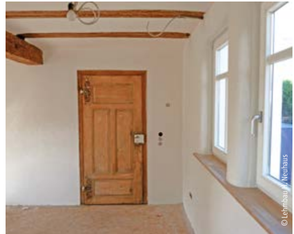
Reine Lehmputze bestehen lediglich aus Lehm, Sand und Wasser. Nach dem Austrocknen sorgen sie für ein gesundes Raumklima und wirken als Feuchteausgleich.
