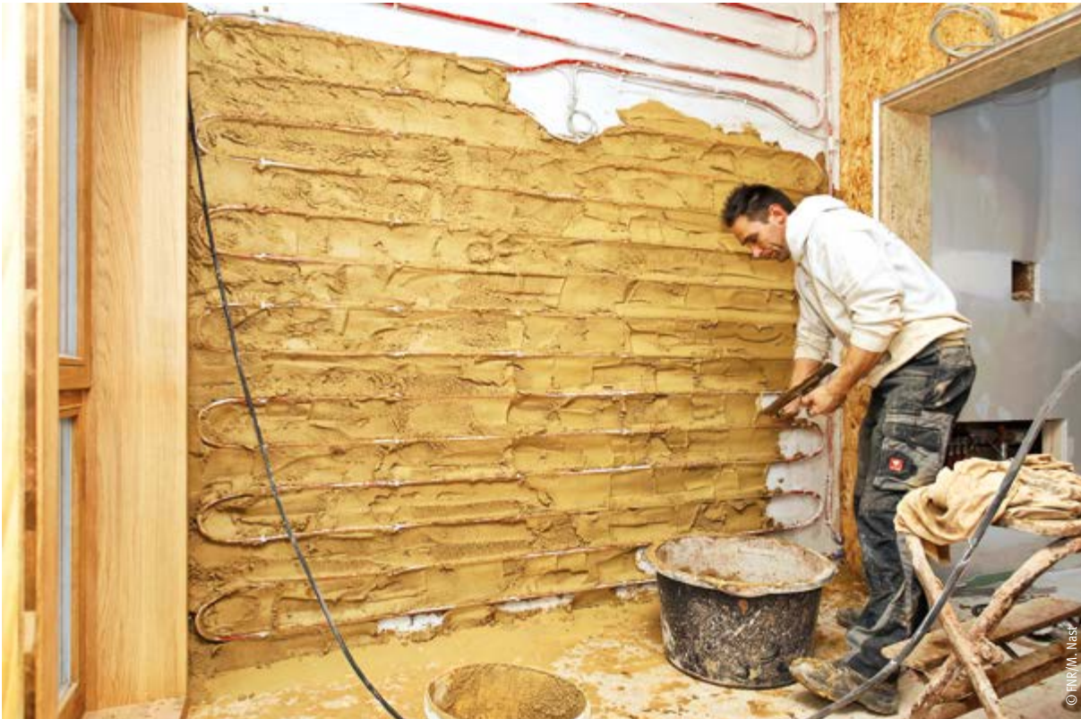
Lehmauftrag auf Wandheizung
