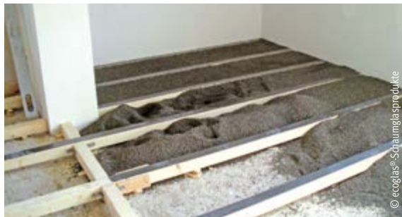
Auffüllen eines Hohlraumes mit Glasschaumschotter
