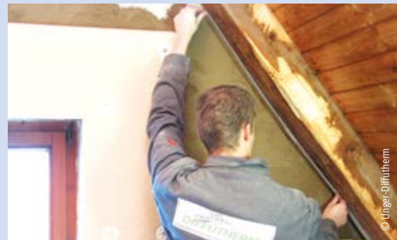
Komriband einlegen für Anschluss an Sparren.
