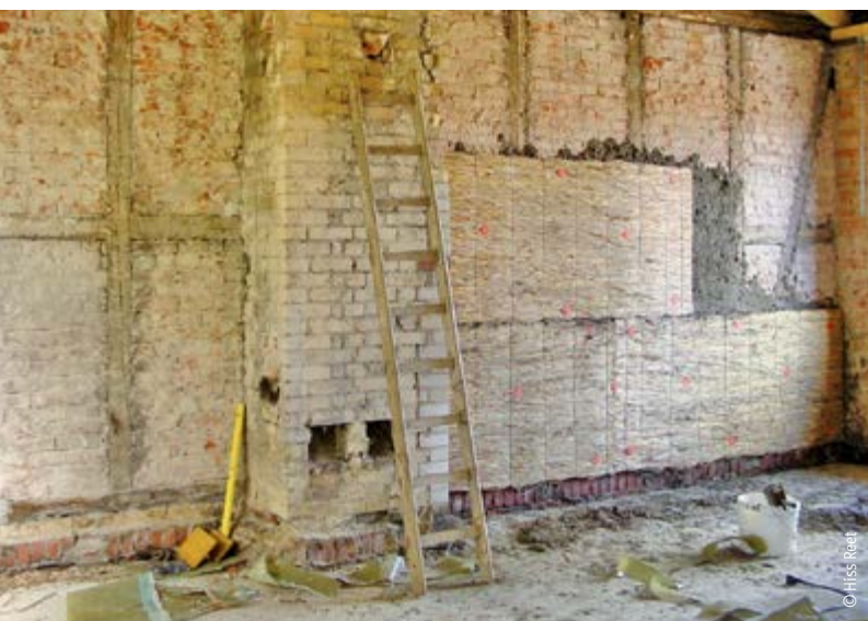
Innendämmung mit Schilfrohr-Dämmplatten
