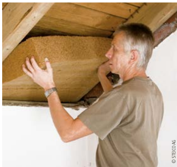
Einbringen einer flexiblen Dämmmatte
