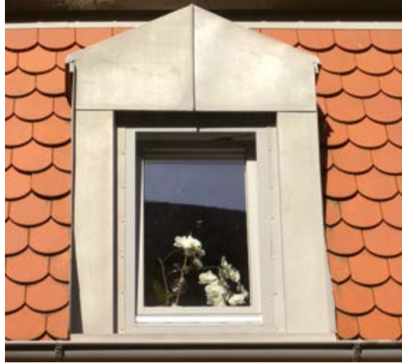
Gaubeneindeckung mit Edelstahlblech
