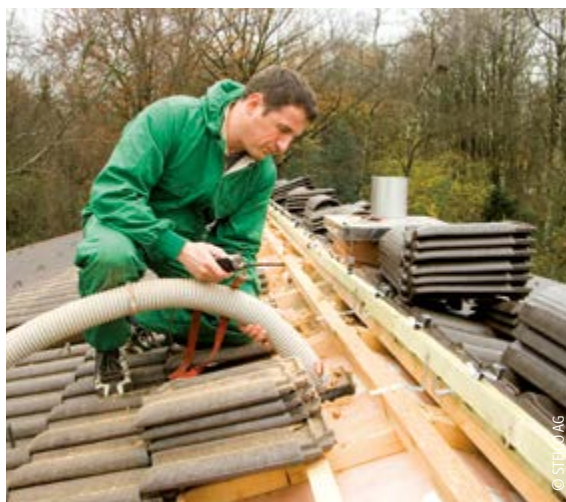
Einblasen von Dämmstoff
