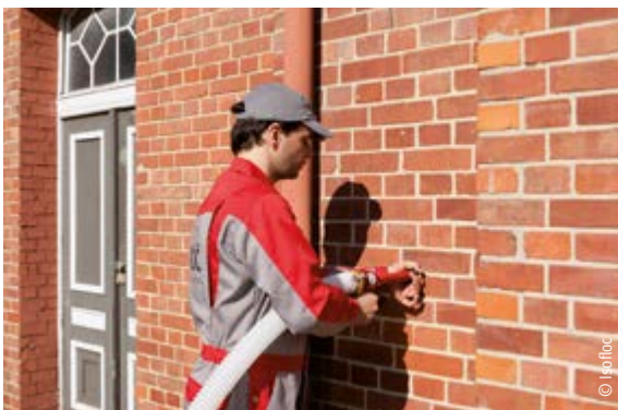
Nachträgliche Einblasdämmung bei zweischaligem Mauerwerk
