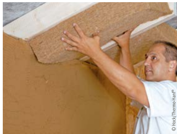
Dachdämmung mit Hanffasermatten
