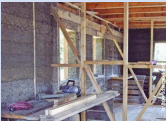
Mit Lehm verputzte Dämmebene
