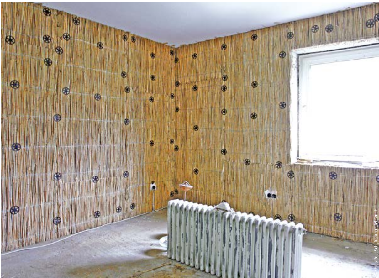
Innendämmung mit Schilfrohrdämmplatten
