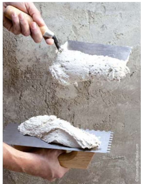
Gips wird mit einer Zahnkelle aufgetragen.
