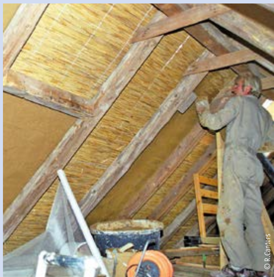
80 mm Schilfrohrplatten als Zwischensparrendämmung und Putzträger für Lehmputz (der zugleich als Brandschutz dient)
