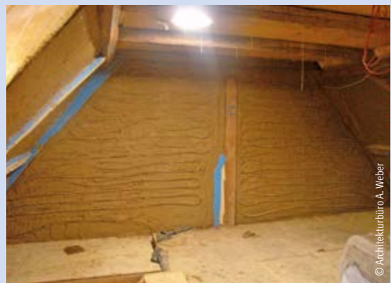
Einschlänmen der Heizrohre in Lehmgrundputz
