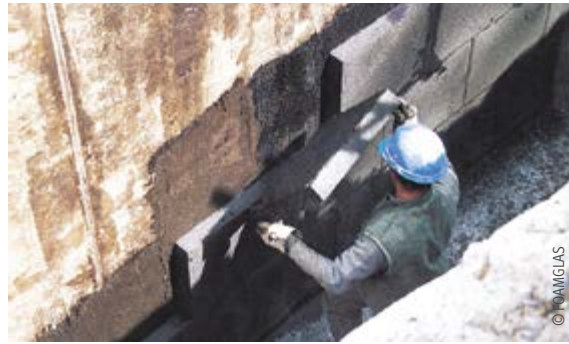
Befestigung von Glasschaumplatten an der Außenwand
