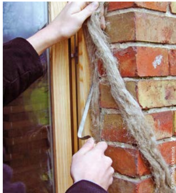
Ausstopfen von Bauteilfugen mit Hanf
