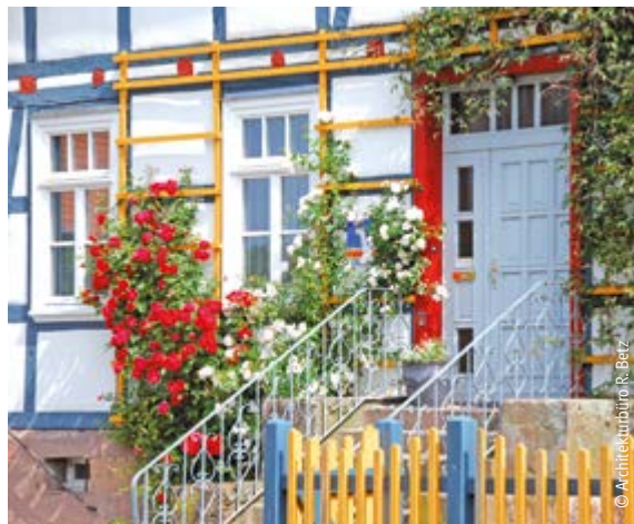
Oft ist der Weg weit, bis ein altes Haus in neuem Glanz erstrahlt.
