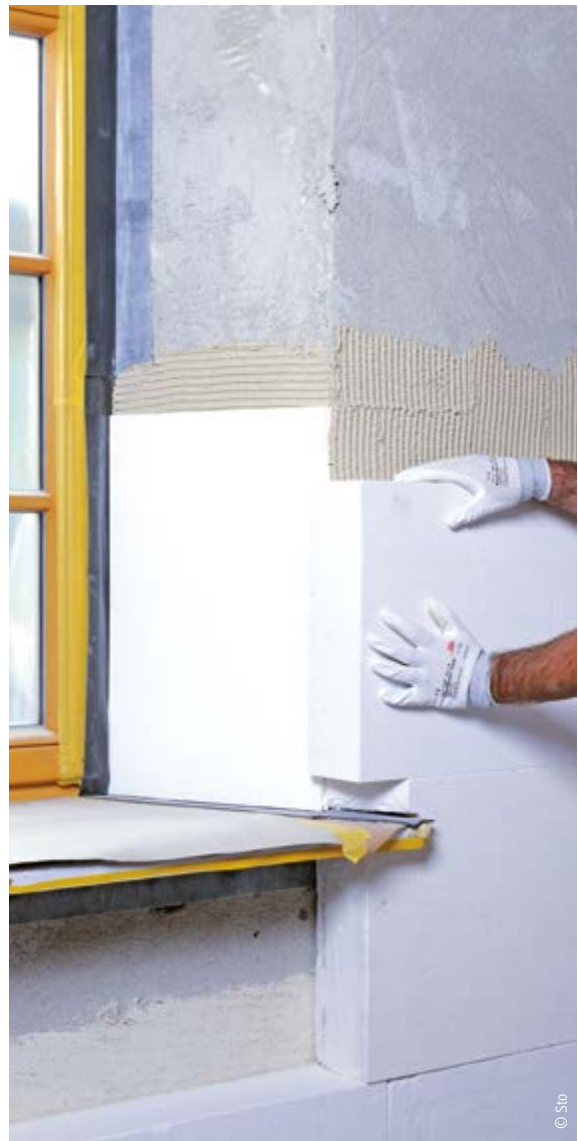
Innendämmung mit Perliteplatten
