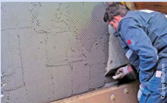
Lehmmörtel vollflächig mit Zahnkelle auftragen.
