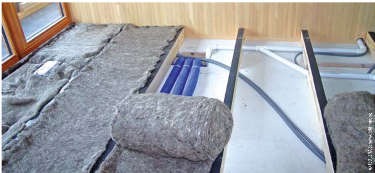
Fußbodendämmung mit Schafwollmatten
