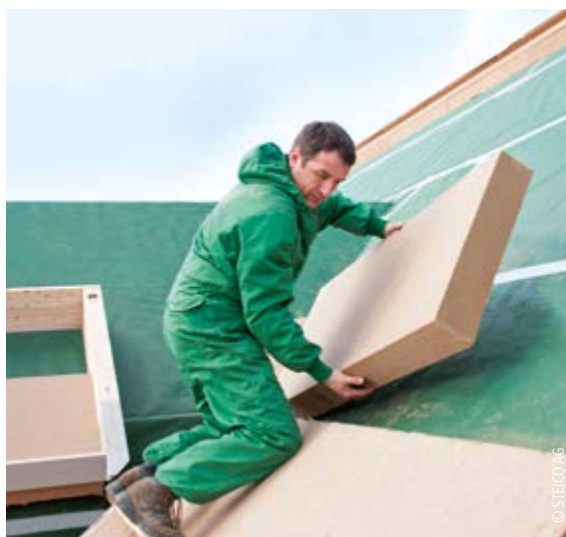
Aufbringen einer Aufsparrendämmung
