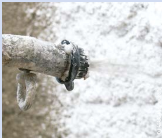
Aufbringen eines Wärmedämmputzes mittels Putzmaschine
