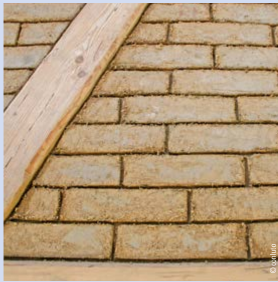
Mit dem Verputzen warten, bis Fugenmörtel augenscheinlich trocken ist. Lehmputz zweilagig mit Armierungsgewebe. Anstrich vorzugsweise mit Kalk-Kasein-Farbe.
