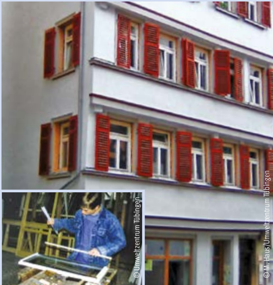
Thermische Verbesserung durch außen liegende Isolierverglasung
