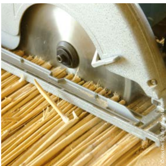
Zuschnitt von Schilfdämmplatten mit Handkreissäge
