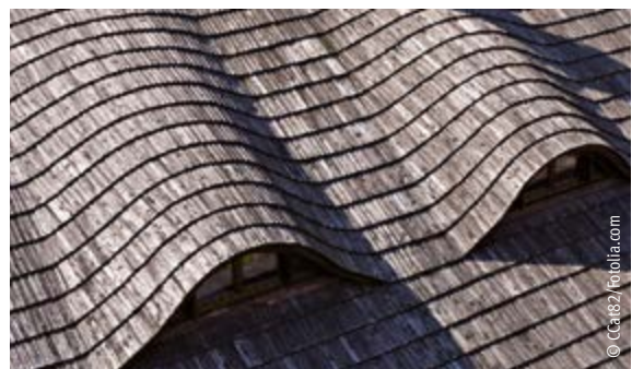
Historische Dachverkleidung mit Holzschindeln
