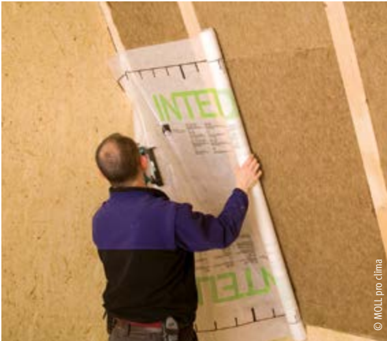
Raumseitiges Anbringen einer feuchteadaptiven („intelligenten“) Dampfbremse
