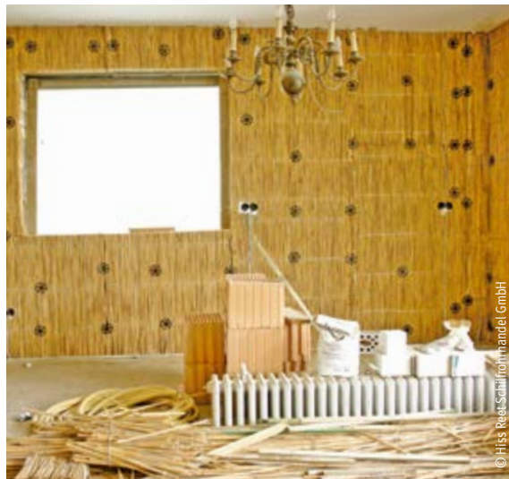
Mit Schilfplatten gedämmter Innenraum
