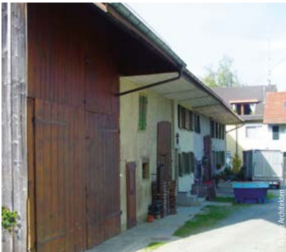
Ehemalige Scheune zum Wohnhaus umgebaut: Die neue, mit Leisten überdeckte und naturbelassene Holzverschalung folgt dem alten Vorbild.
