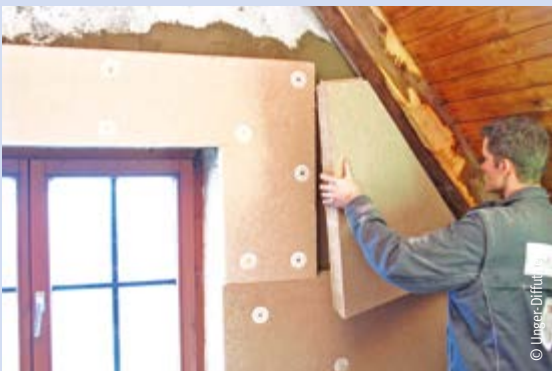
Dämmplatte stumpf an Balken stoßen.
