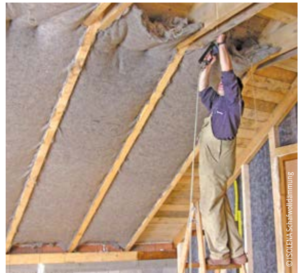
Dachdämmung mit Schafwollmatten
