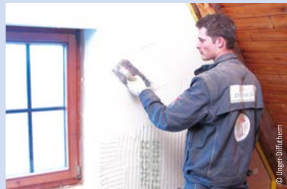
Armierungsgewebe in Kalk- oder Lehmputz einarbeiten.
