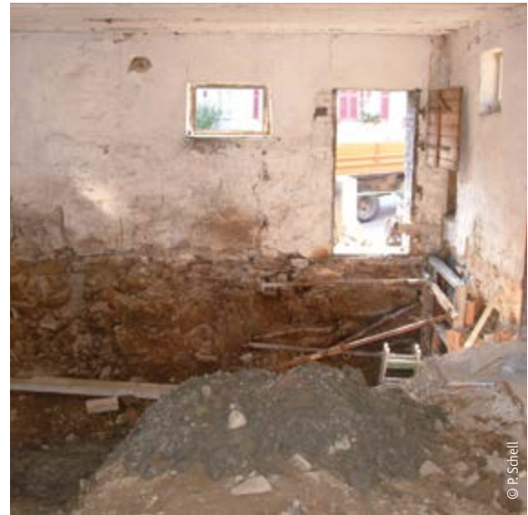
In manch altem Gebäude noch anzutreffen: Fußboden direkt auf Erdreich verlegt. Dann muss der Boden ausgehoben werden – sofern die Statik es erlaubt, bis zur Unterkante des Fundaments.
