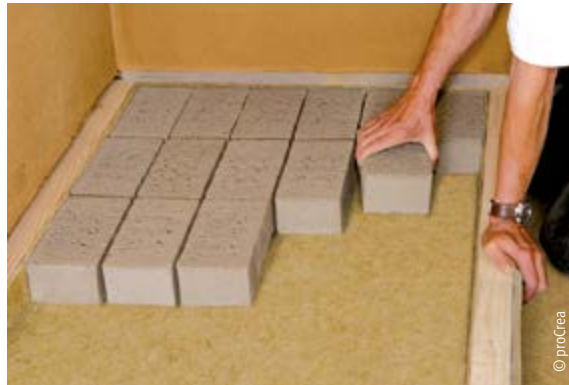
Einbau der Lehmsteine auf Hanffilzmatte (= schalltechnische Verbesserung)
