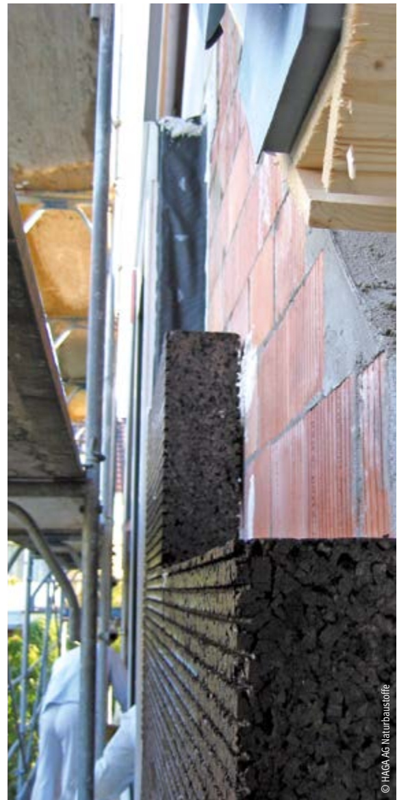
Korkdämmplatten als Fassadendämmung
