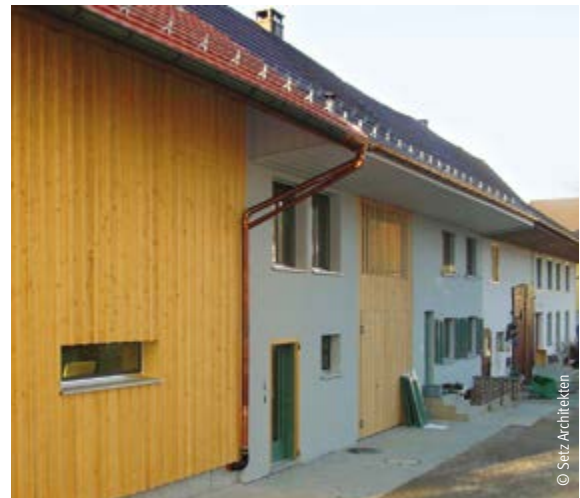
Ehemalige Scheune zum Wohnhaus umgebaut: Die neue, mit Leisten überdeckte und naturbelassene Holzverschalung folgt dem alten Vorbild.
