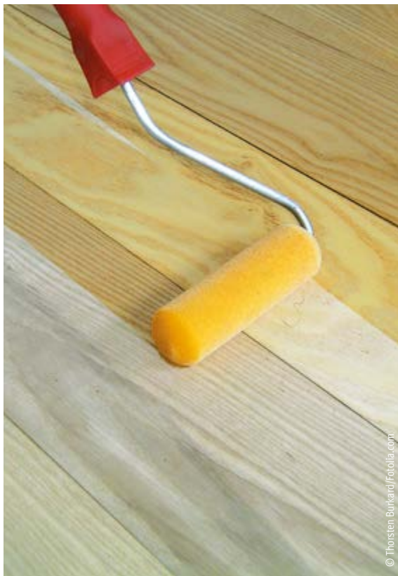
Auftrag von Fußbodenöl auf neuer Holzdielung
