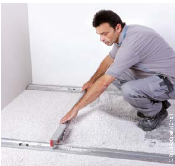
Perlite verzahnt sich zu einer nachverdichtungsfreien, stabilen Ausgleichs- und Tragschicht.
