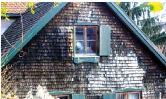
Verkleidung mit gesägten Holzschindeln
