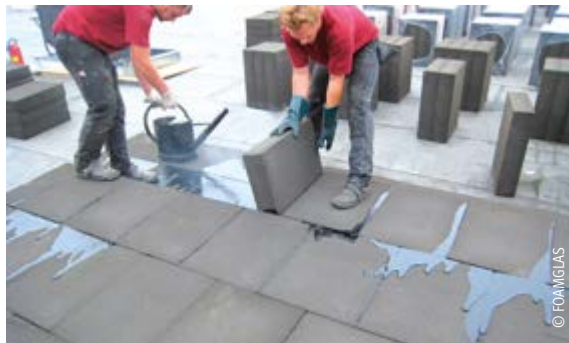
Verlegung von Glasschaumplatten
