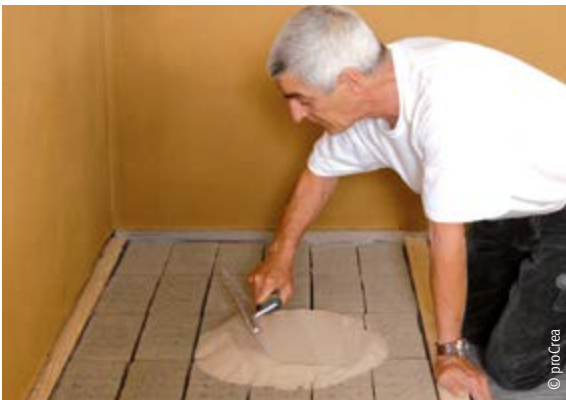
Auffüllen der Fugen mit Quarzsand
