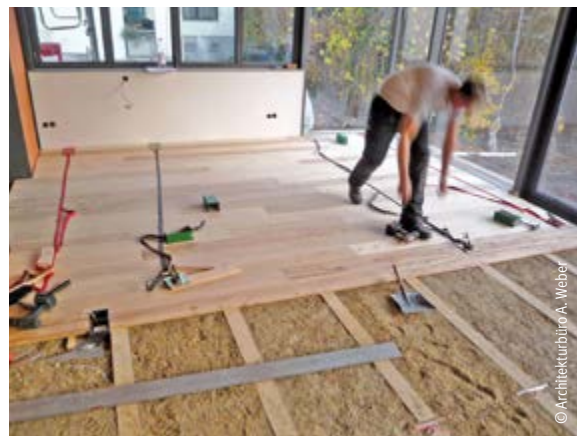
Ulmenmassivparkett auf Fußbodenheizung in Stampflehmbett
