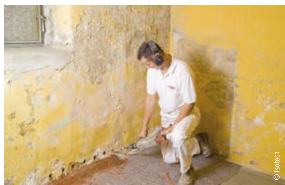
Vorbereitung zur Bohrlochtränkung
