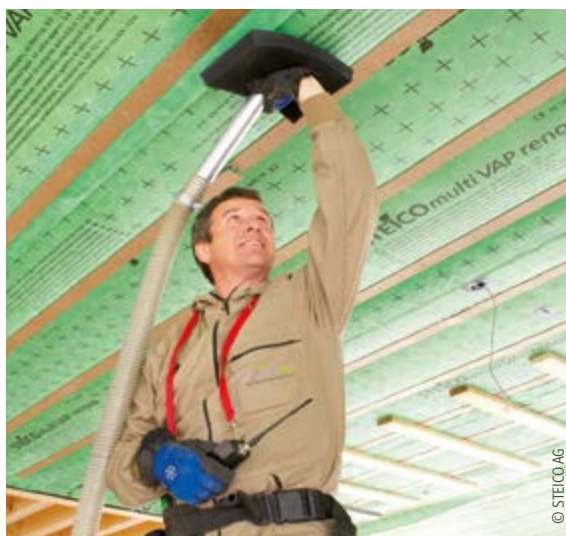
Dämmung der Zwischendecke mit Einblasdämmstoff
