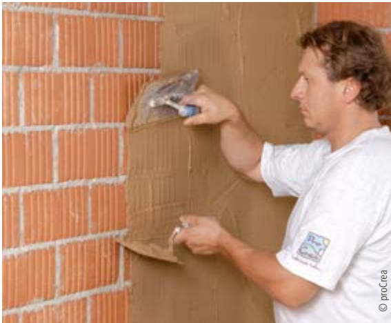
Auftrag des Grundputzes
