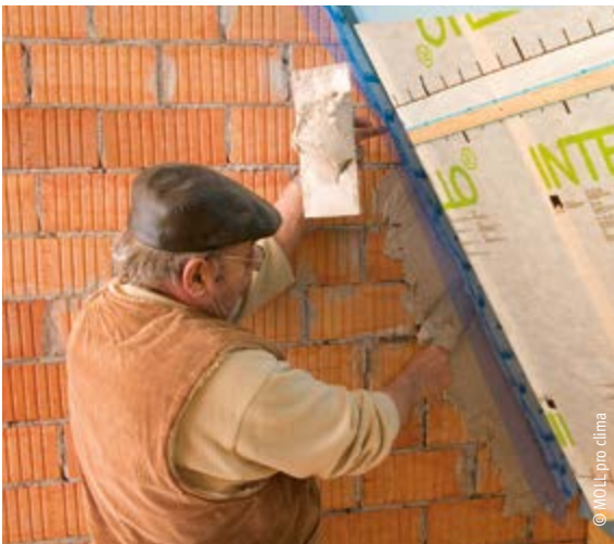
Einputzen des Dichtungsbandes
