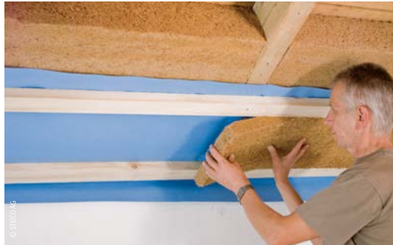
Ausfüllen der Installationsebene mit natürlichem Dämmstoff
