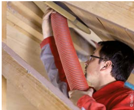
In einen vorbereiteten Dachhohlraum wird Zellulose eingeblasen.
