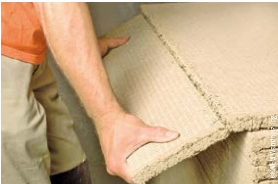
Ablängen einer Lehmbauplatte
