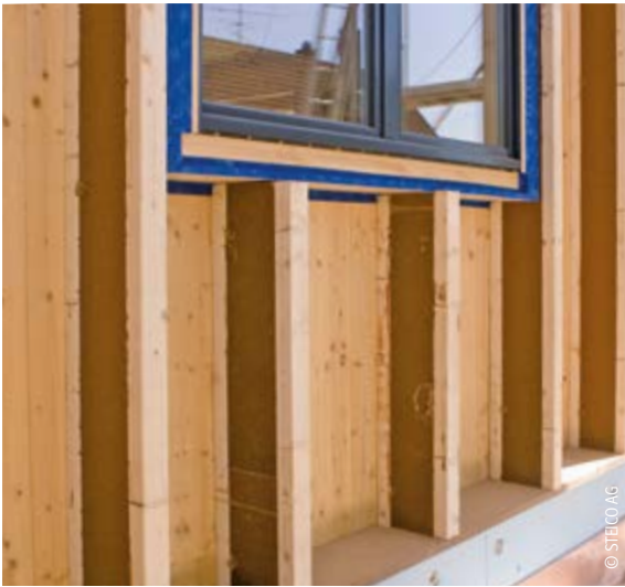
Tragsystem aus vorgefertigten Doppelstegträgern – für Einblas- und Einklemdämmung geeignet
