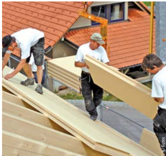
Wärmebrückenfreie Aufsparrendämmung mit wasserabweisenden Holzfaserdämmplatten
