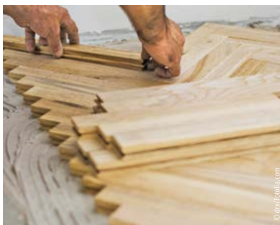
Verlegung von Stabparkett
