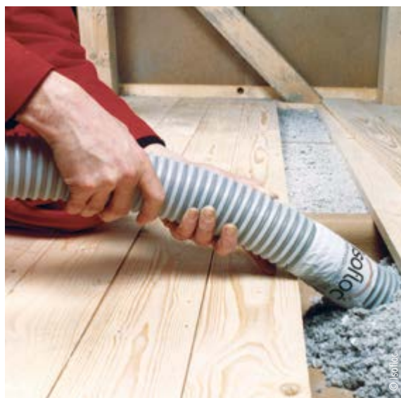
Einblasdämmung als Wärme- und Luftschalldämmung unter Fußböden
