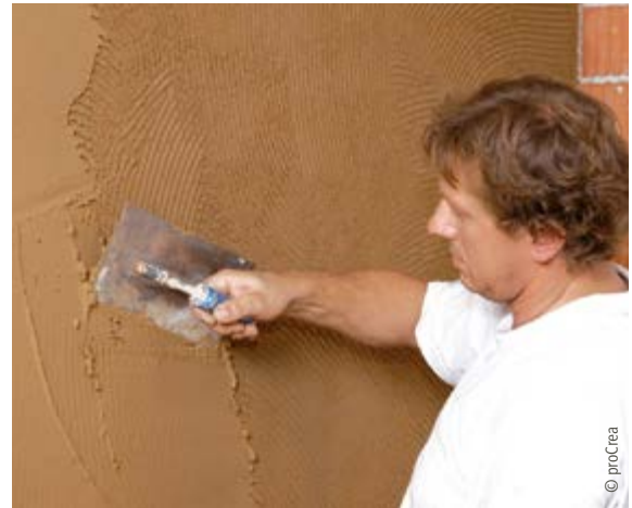
Auftrag des Oberputzes auf Grundputz
