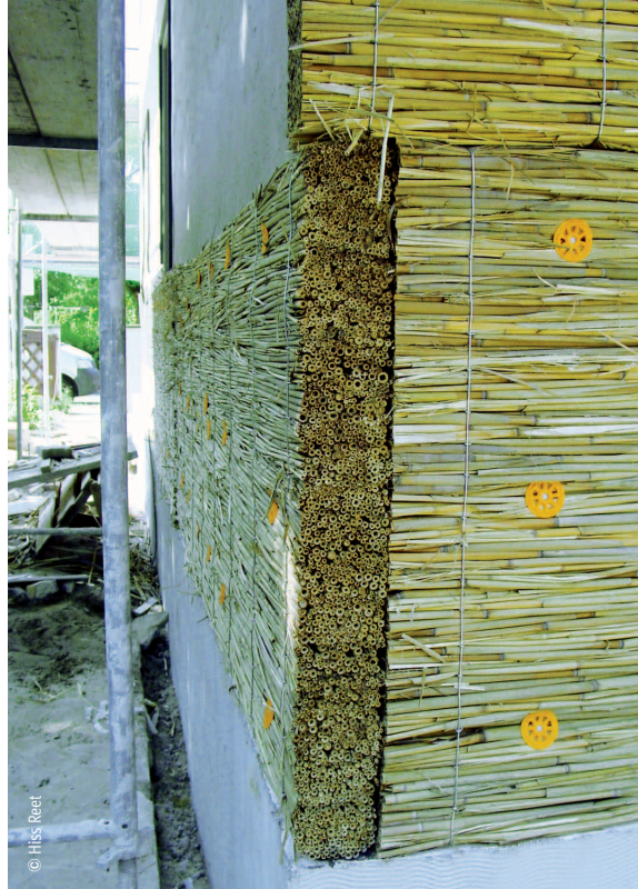
Mit Schilfplatten gedämmte Hausecke
