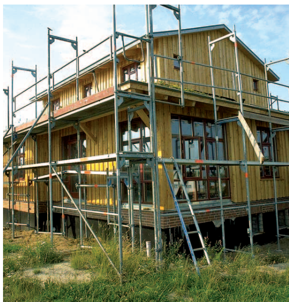
Holzhausbau mit Flachsdämmung
