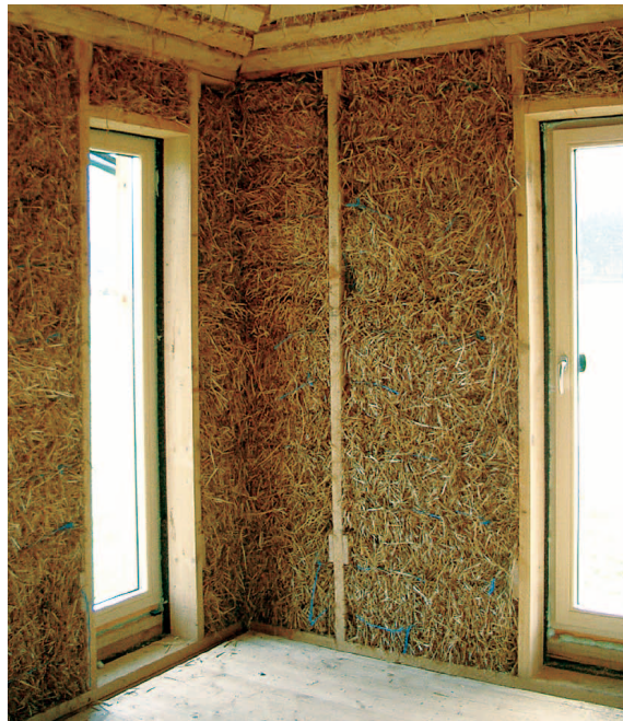
Innenansicht einer Holzrahmenkonstruktion mit Strohballendämmung
