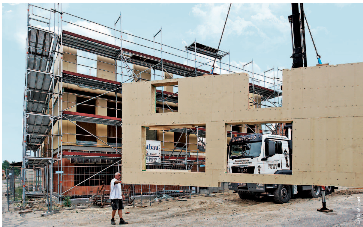
Vorgefertigte Außenwandelemente mit Holzfaserdämmung
