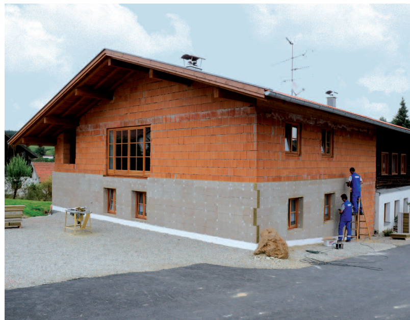
Außendämmung mit Holzwole-Dämmplatte
