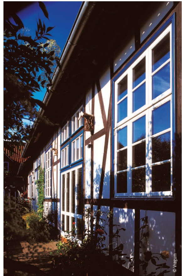
Fachwerkhaus mit Innendämmung
