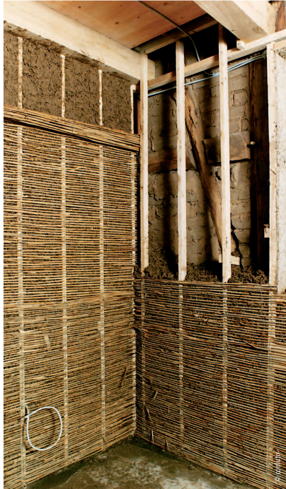
Konstruktion für eine Dämmschüttung
