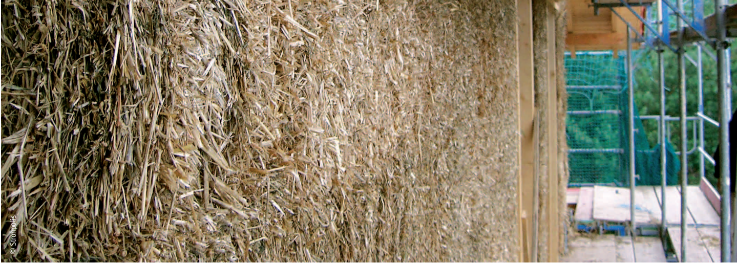
Strohballen zwischen einer Holzrahmenkonstruktion (außen)
