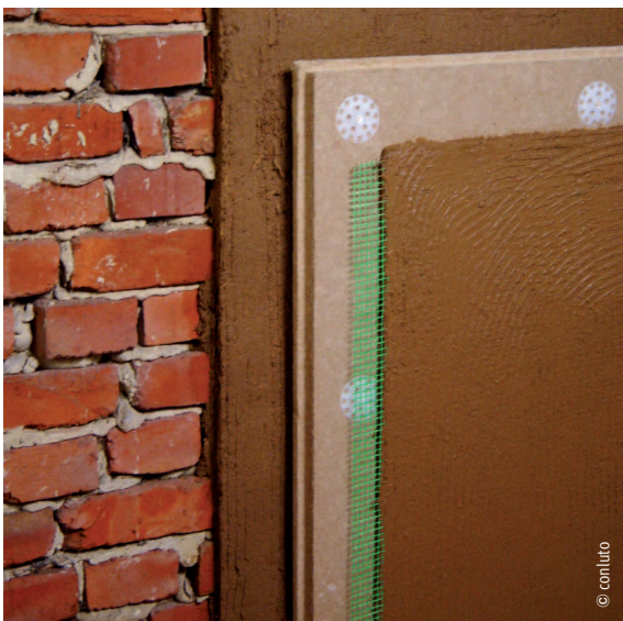
Innendämmung mit Holzfaserdämmplatten
