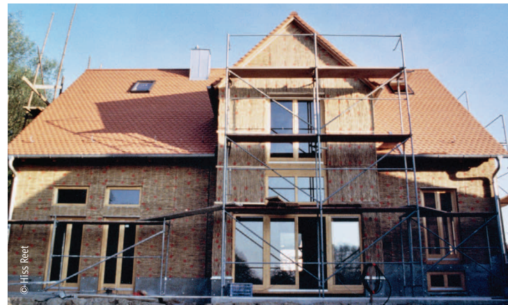
Schilf als Putzträger an der Außenfassade
