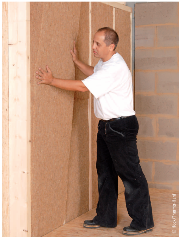
Einbau einer flexiblen Hanfdämmmatte
