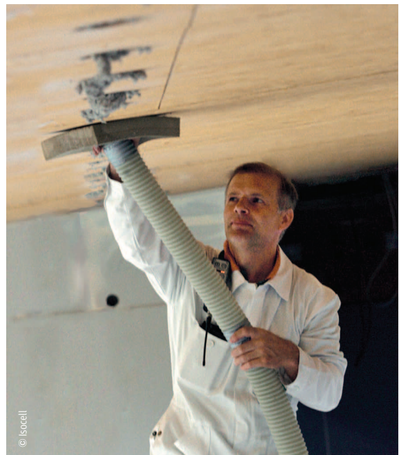
Zelluloseeinblasung in der Decke
