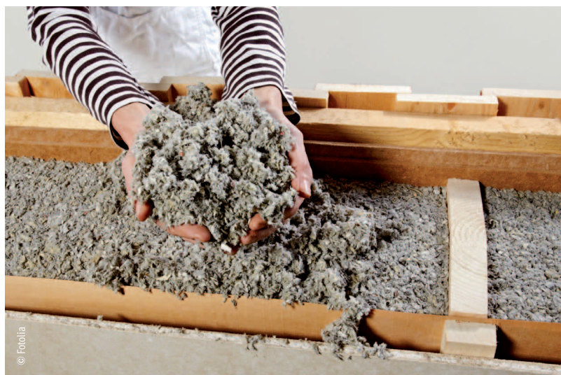
Zelluloseeinblasdämmung in einer Außenwand
