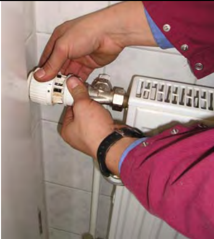
Der Thermostatkopf des vorhandenen Ventils wird zur Voreinstellung des Ventils abgenommen.
