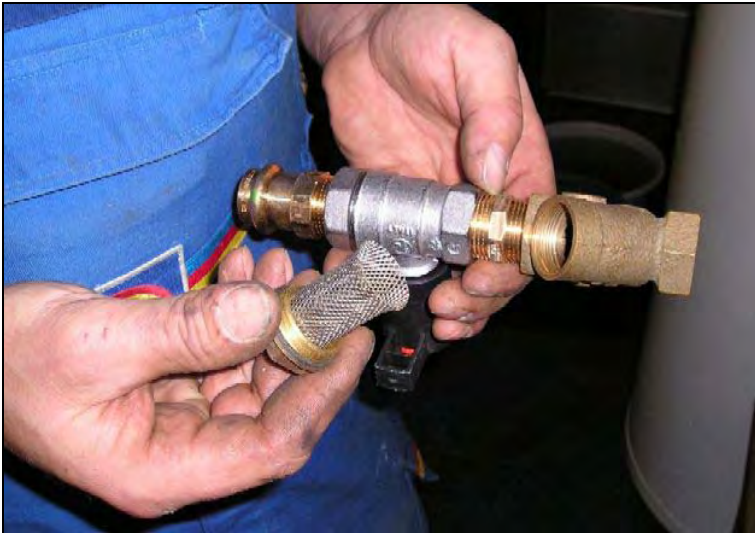
Bild 82 Schmutzfilter vor dem Einbau
