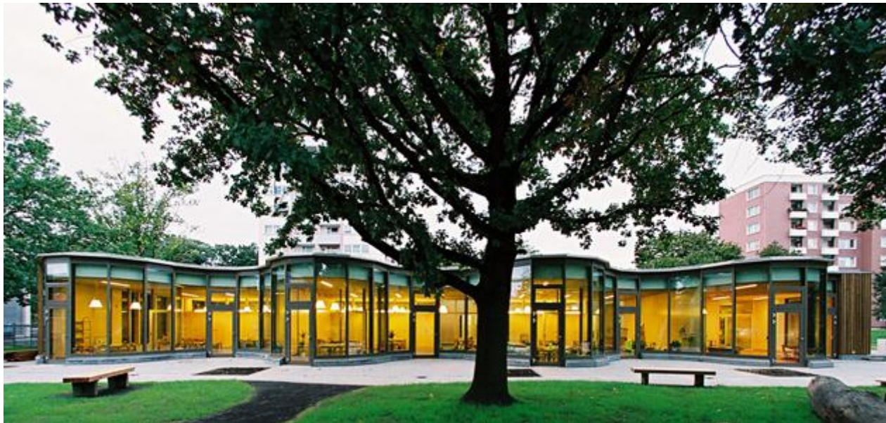
Foto: despang Architekten
