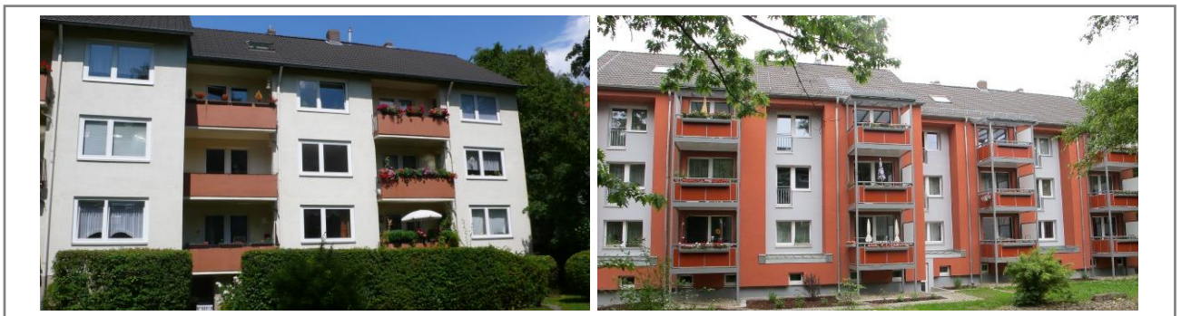
Abbildung 1: Vor (links) und nach (rechts) der Sanierung der nördlichen Hauszeile
