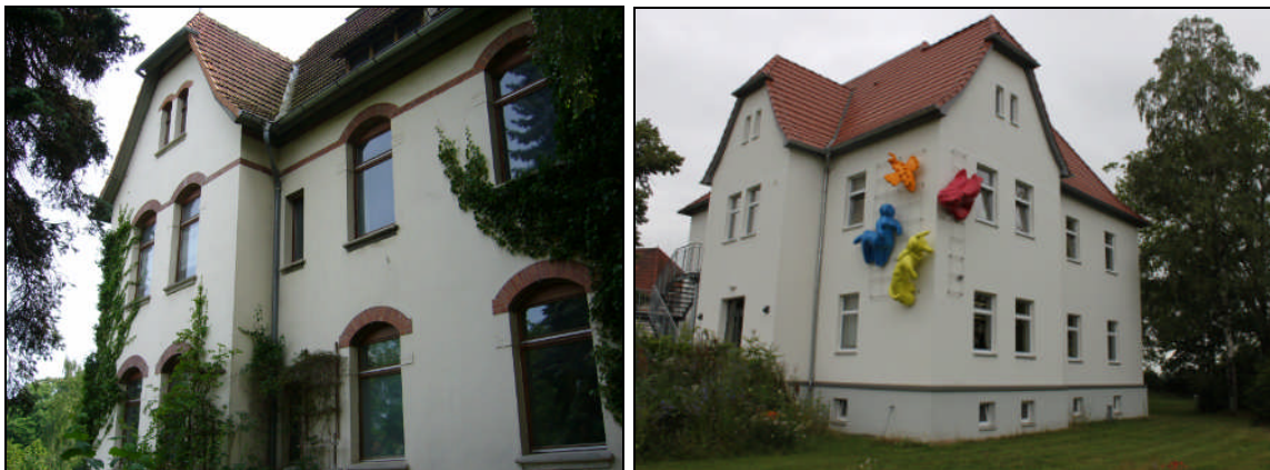
Bild 55 Neuerkerode, Wohnhaus I im Bestand, nach der Modernisierung Villa Luise
