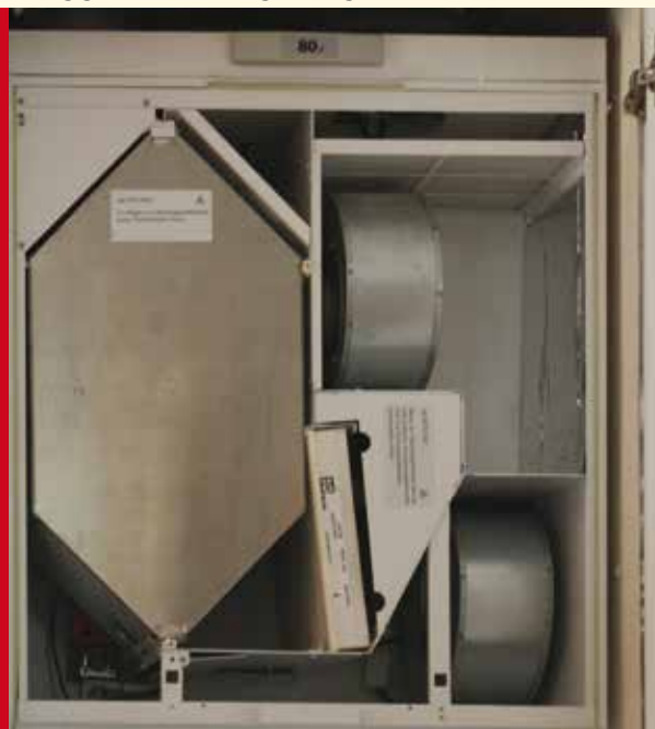
Lüftungsgerät mit Wärmerückgewinnung
