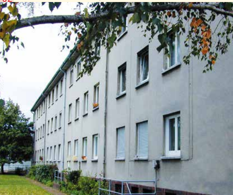
02 Altbau vor der Sanierung | Frankfurt am Main
