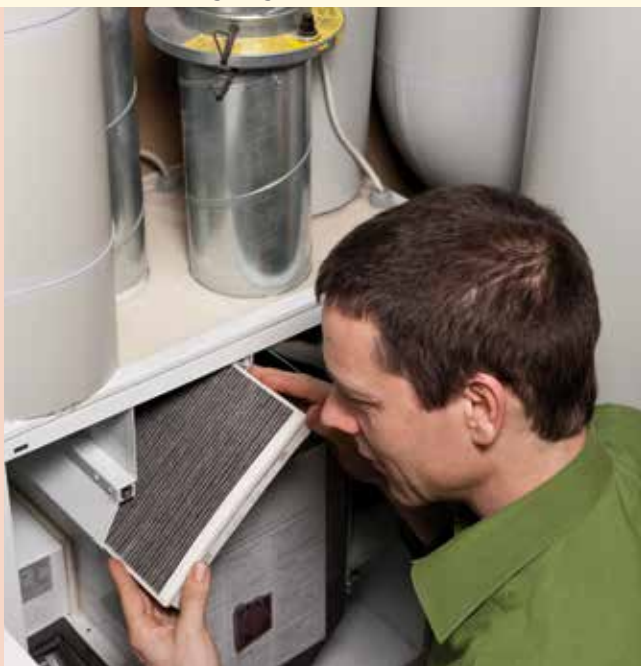
Filterwechsel an der Lüftungsanlage
