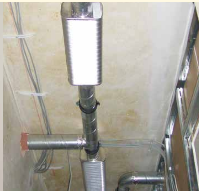
Zuluftkanalnetz im Rohbau
