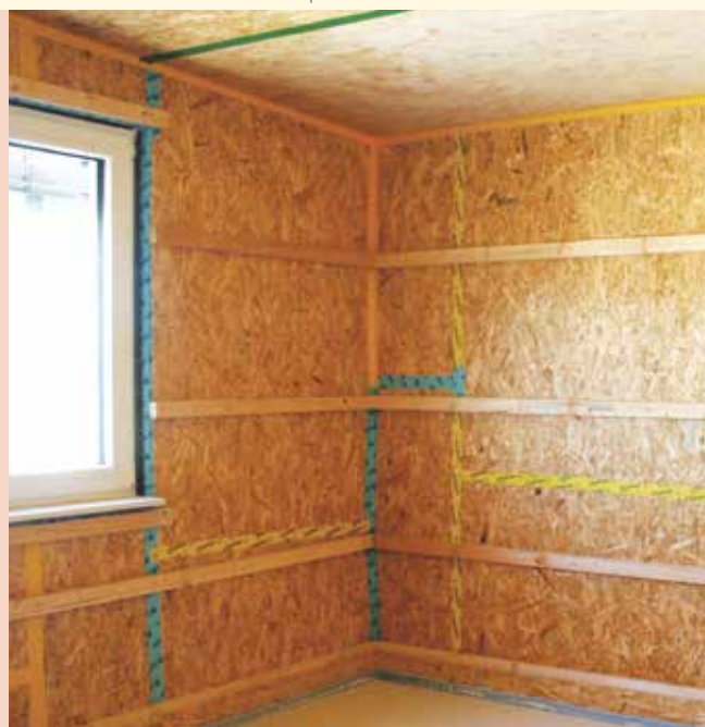
Luftdicht verbundene Holzwerkstoffplatten
