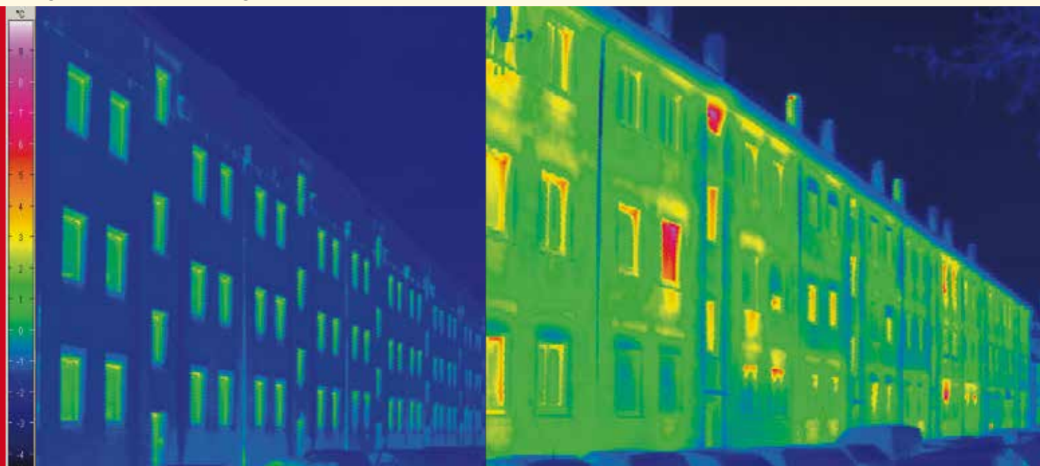
Thermografieaufnahme nach der Sanierung (links) und vorher (rechts)
