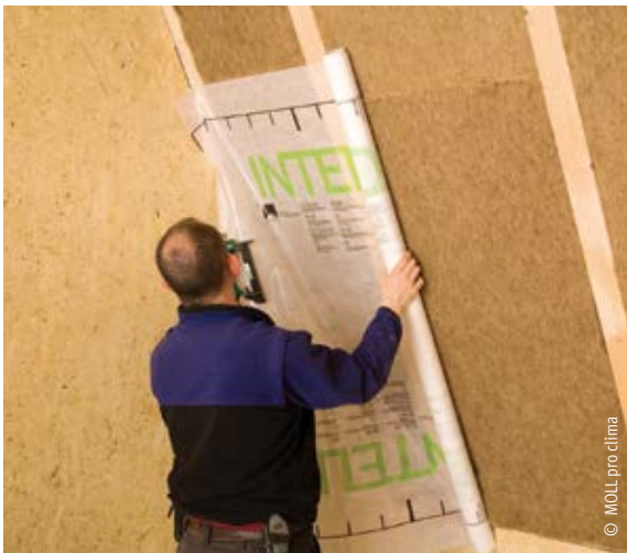
Raumseitiges Anbringen einer feuchteadaptiven („intelligenten“) Dampfbremse
