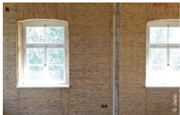
Mit Lehmörtel angesetzte Innendämmung aus Schilfrohrplatten
