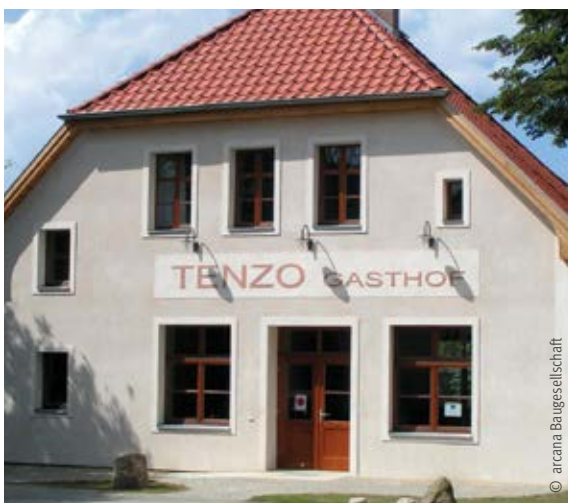
Mit reinem Kalkmörtel verputzte Fassade
