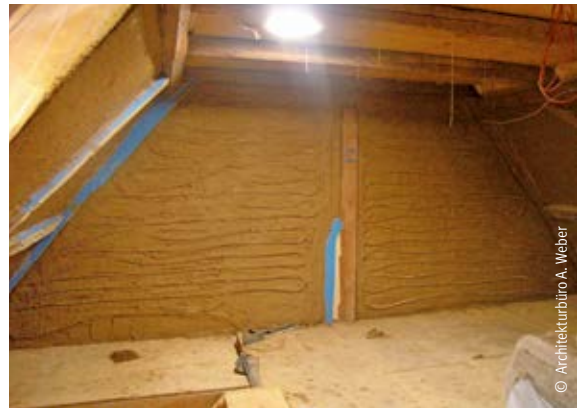
Einschlämmen der Heizrohre in Lehmgrundputz auf Schilfrohrplatten
