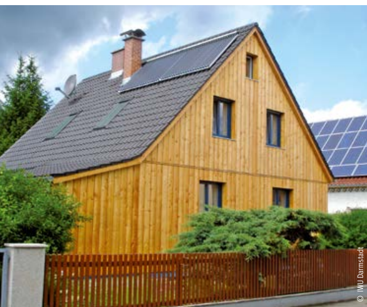
Holzfassade mit Boden-Deckel-Schalung
