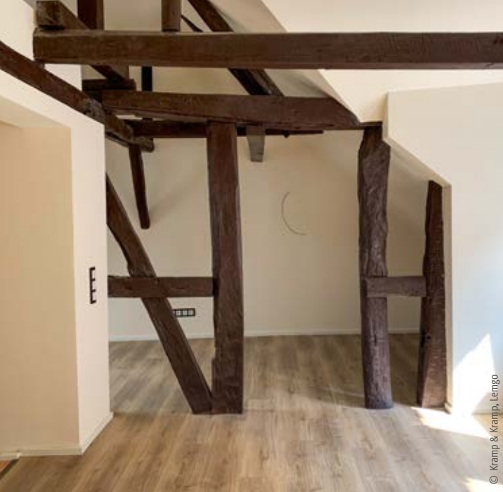
Dachgeschossausbau im Fachwerkhaus
