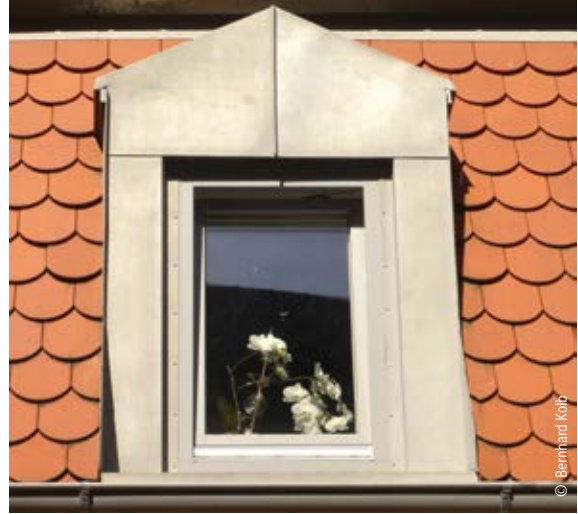
Dacheindeckung mit naturroten Biberschwanzziegeln, Gaubeneindeckung mit Edelstahlblech
