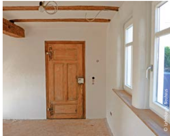
Reine Lehmputze bestehen lediglich aus Lehm, Sand und Wasser. Nach dem Austrocknen sorgen sie für ein gesundes Raumklima und wirken als Feuchteausgleich.
