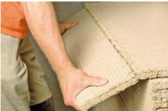
Ablängen einer Lehmbauplatte
