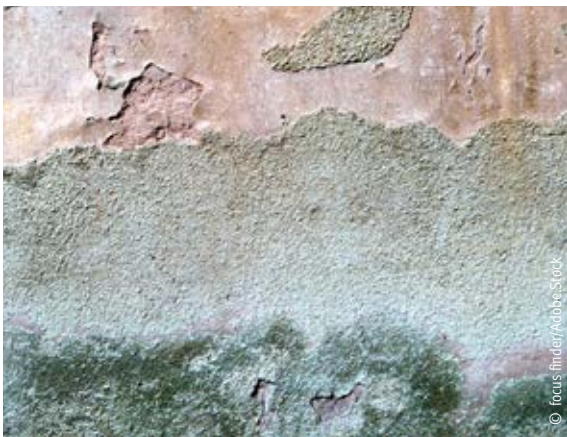
Schadhafte Putzoberfläche
