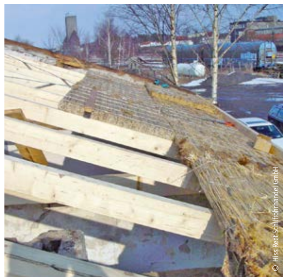
Aufdachdämmung mit Schilfrohrdämmplatten
