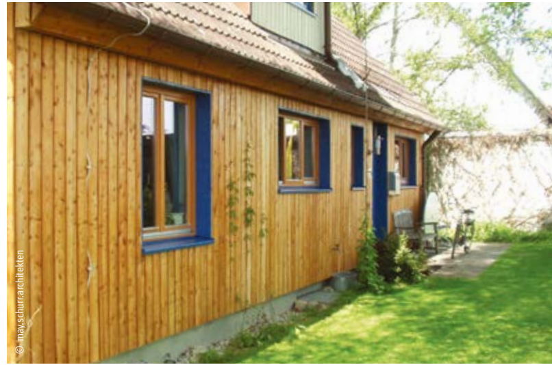
Einfamilienhaus in Apfeltrach: Hinterlüftete Vorhangfassade (rechts) mit Holzverschalung und Zellulosedämmung, Zellulose aufgesprüht in Konterlattung (links) 2 • 6 cm
