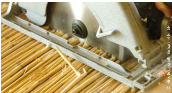
Zuschnitt von Schilfdämmplatten mit Handkreissäge
