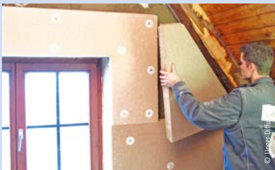
Dämmplatte stumpf an Balken stoßen.
