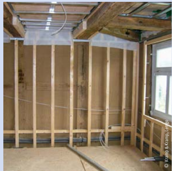
Holzständerwerk in Vorbereitung zur Einblasdämmung
