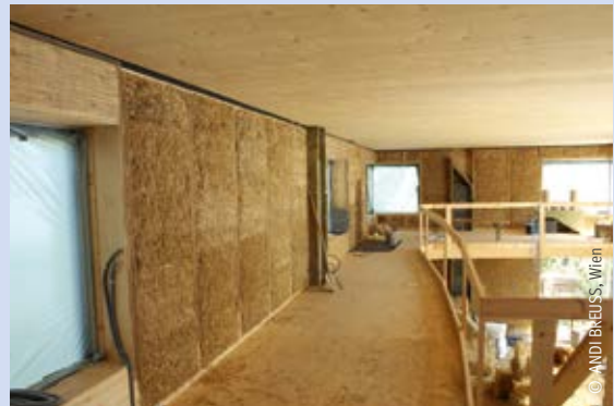
35 cm Strohballen aus dem benachbarten Getreidefeld als effiziente und diffusionsoffene Dämmung
