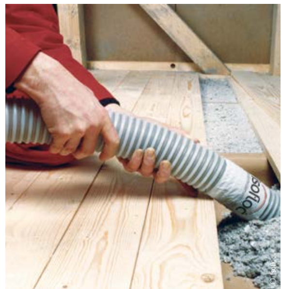
Einblasdämmung als Wärme- und Luftschalldämmung unter Fußböden
