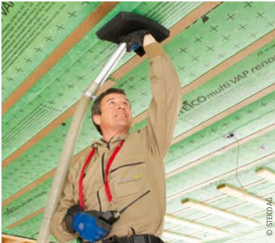
Dämmung der Zwischendecke mit Einblasdämmstoff
