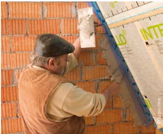
Mauerwerksanschluss: Einputzen des Dichtungsbandes mit Glattstrich
