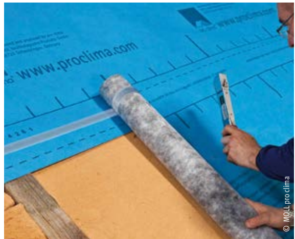
Befestigung einer Unterspannbahn auf der Außenseite der Sparren
