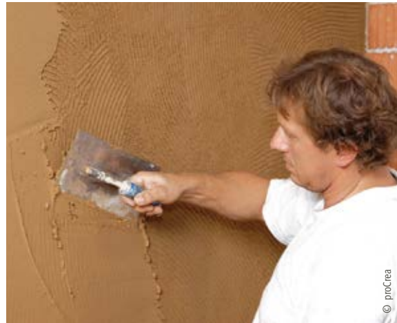
Auftrag des Oberputzes auf Grundputz
