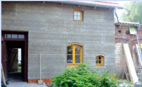
Vorhangfassade mit Heraklithplatte und Korkschtüttung. Abdichten der Fugen zwischen Mauerwerk und Tragsystem mit Hanf- oder Flachszipf wird empfohlen, um ein Hinterströmen der Konstruk- tion mit Kaltluft sicher auszuschließen.
