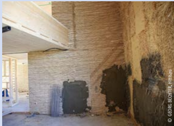
Lehmputz aus der eigenen Baugrube.
