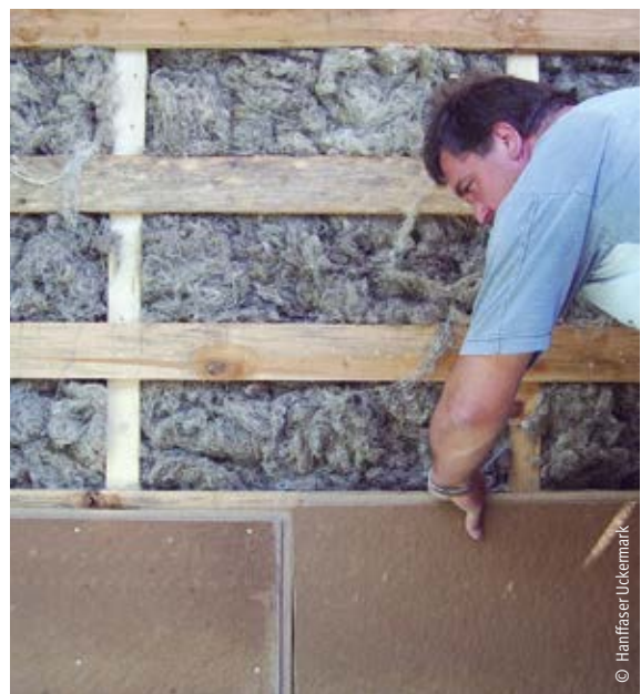
Innendämmung mit Hanfstoppwole und verputzbarer Holzfaserplatte
