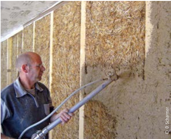
Aufbringen des Lehmputzes mittels Putzmaschine
