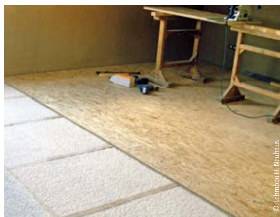
Hohlraumfüllung mit Perlite, Abdeckung mit OSB-Platten
