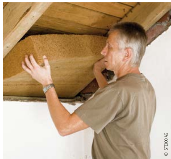
Einbringen einer flexiblen Dämmmatte
