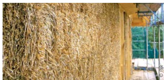
Stroh zwischen einer Holzrahmenkonstruktion (außen)
