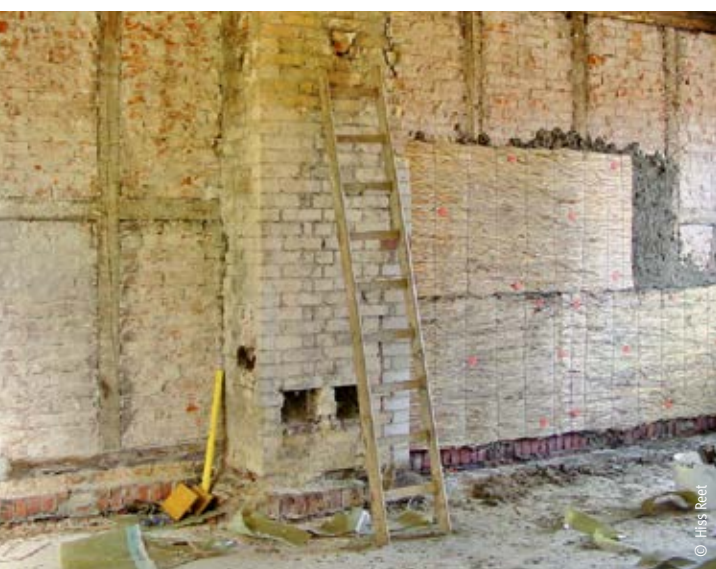
Schilfrohrplatten als Innendämmung und Putzträger
