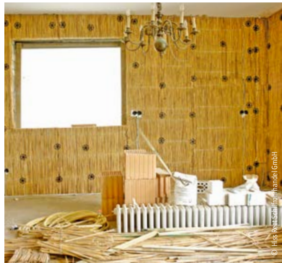
Mit Schilfplatten gedämmter Innenraum
