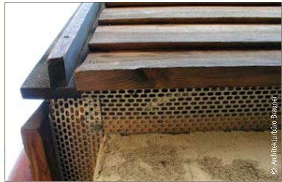
Belüftungsbleche im Sockelbereich: Stülpschalung in handwerklich sauberer Eckausbildung. So haben die Stirnseiten der Bretter Luft zum Trocknen.
