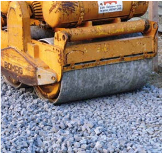
Schaumglasschotter als kapillarbrechende Wärmedämm- und Tragschicht
