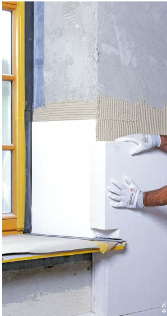
Innendämmung mit Perliteplatten
