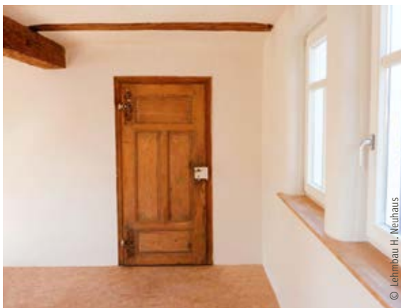
Lehmbau Neuhaus, Ronneburg Mit Lehmfarbe und Lehmfeinputz, Laibungen gerundet (= Vermeidung von Putzleisten)
