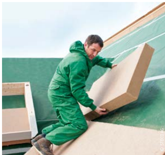
Aufbringen einer Aufsparrendämmung
