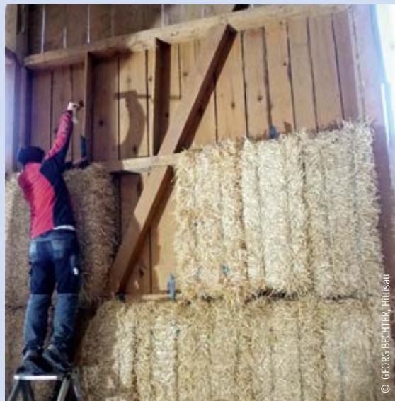
Einbringen der 38 cm dicken Strohbällen in bestehendes Riegelwerk
