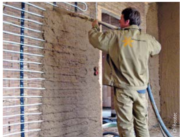
Aufspritzen des Lehm-Grundputzes auf ein frei verlegtes Rohrsystem
