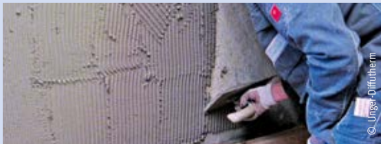
Lehmmörtel vollflächig mit Zahnkelle auftragen.
