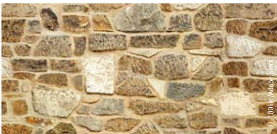
Gemauerte Bruchsteinwand
