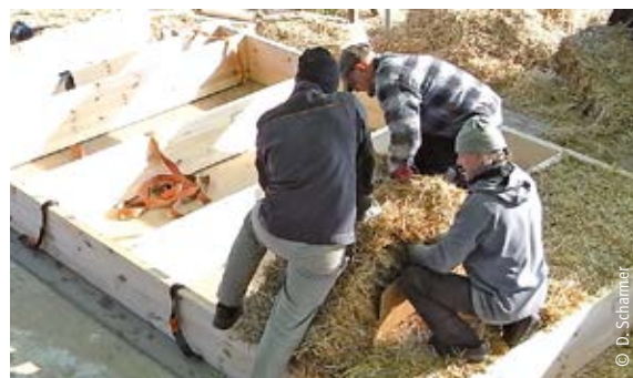
Ausfachung von vorgefertigten Holzbaulementen mit Strohballen ab einer Dicke von 40 cm
