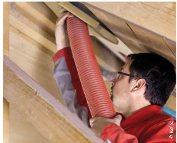
In einen vorbereiteten Dachhohlraum wird Zellulose eingeblasen.
