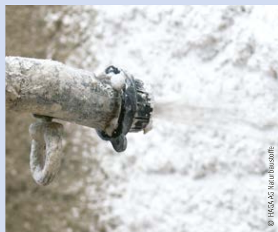
Aufbringen eines Wärmedämmputzes mittels Putzmaschine
