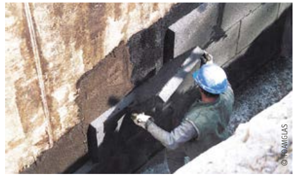
Befestigung von Glasschaumplatten an der Außenwand im Fundamentbereich
