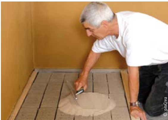
Auffüllen der Fugen mit Quarzsand
