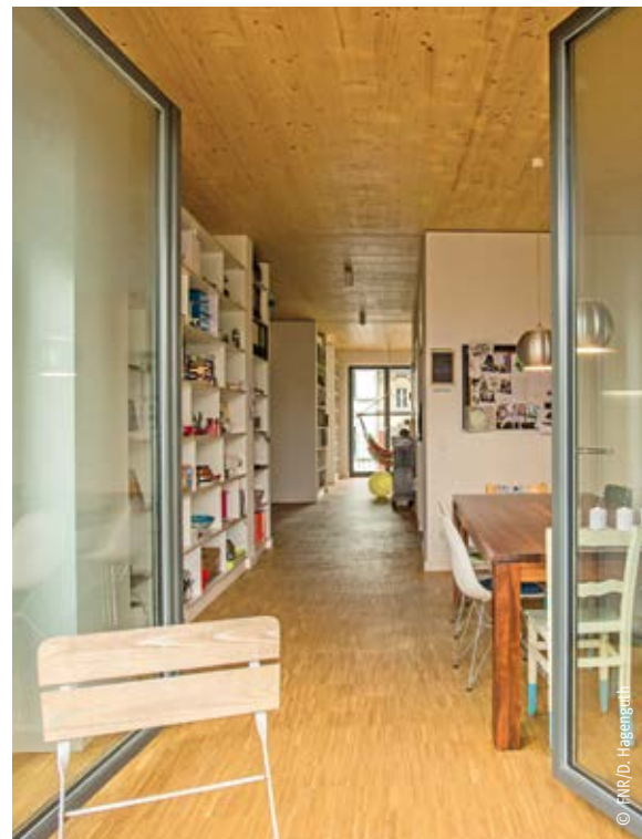
Holz als Bodenbelag und als Massivholzdecke
