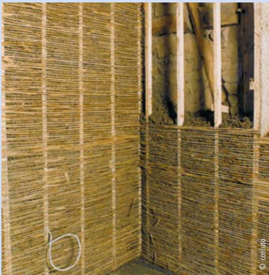
Innenschale aus Leichtlehm: Schilfrohrgewebe als verlorene Schalung auf Holzlattung.
