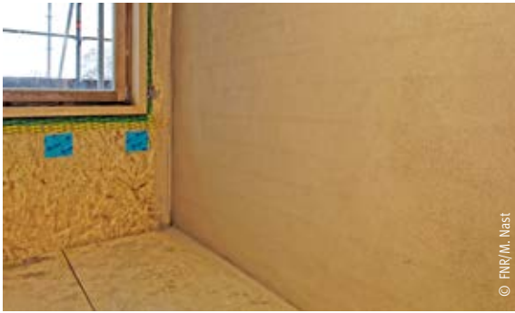
Lehmputz auf Mauerwerk
