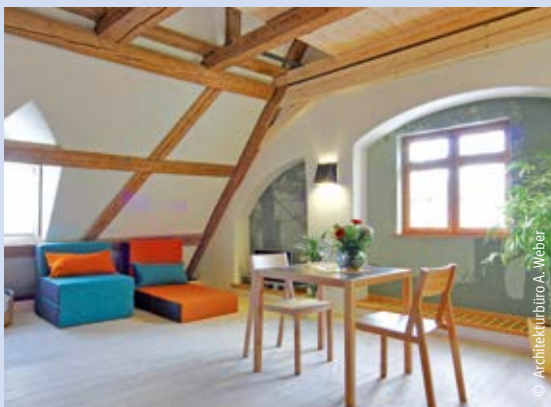
Innenausbau mit Schilfrohrplatten und Wandheizung
