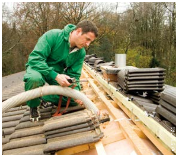
Einblasen von Dämmstoff
