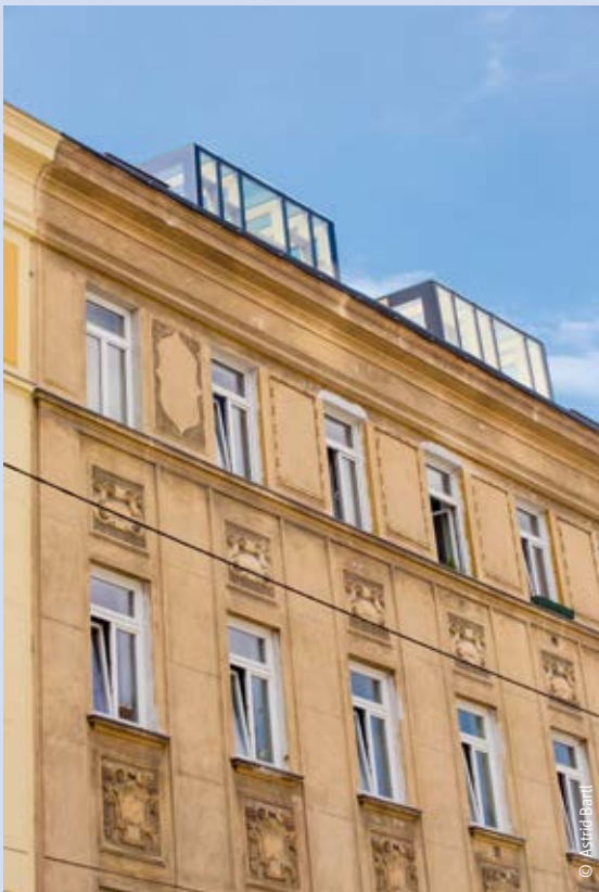
Holzbauteile vorgefertigt, dadurch deutliche Verkürzung der offenen Bauzeit
