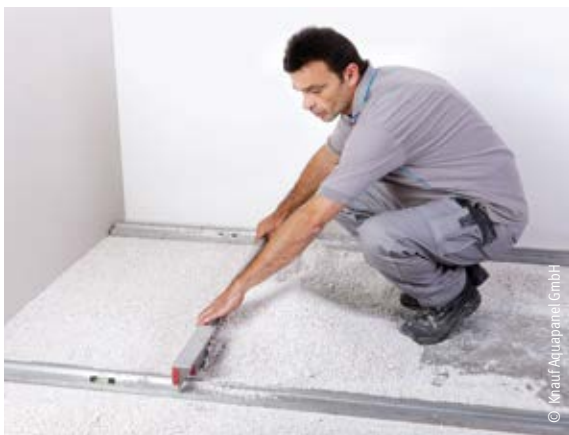
Perlite verzahnt sich zu einer nachverdichtungs-freien, stabilen Ausgleichs- und Tragschicht.
