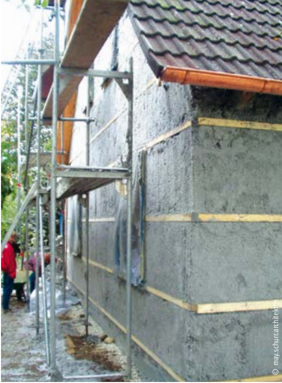
Einfamilienhaus in Apfeltrach: Hinterlüftete Vorhangfassade (rechts) mit Holzverschalung und Zellulosedämmung, Zellulose aufgesprüht in Konterlattung (links) 2 • 6 cm
