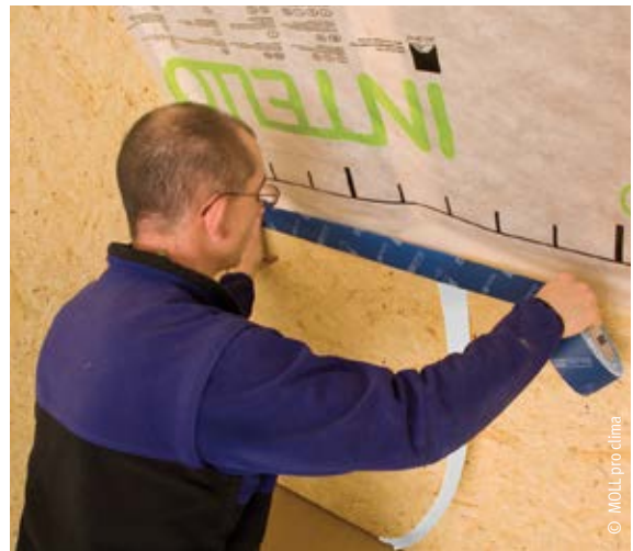
Anschluss an OSB-Platte mit Klebeband
