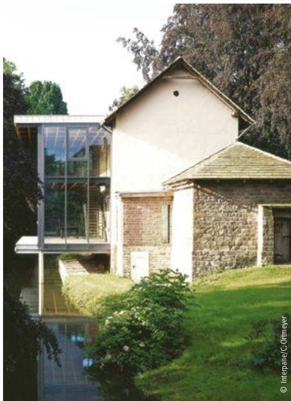
Natursteinmauerwerk, teilweise verputzt; Dacheindeckung mit Buntsandsteinplatten
