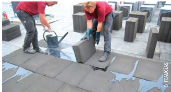
Einschlänmen von Schaumglasplatten in Bitumenbett
