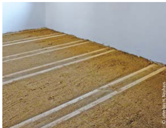
Hohlraumfüllung mit Lehm-Trockenschüttung
