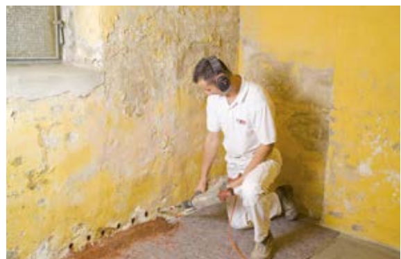
Vorbereitung zur Bohrlochtränkung
