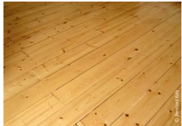
Dielenboden auf Lehmsteindecke
