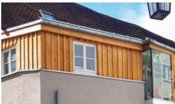
Dachaufstockung als Holzbau mit Holzfassade
