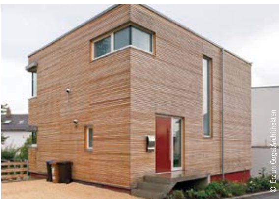
Waagrecht angeordnete Holzlamellenfassade an einem Neubau
