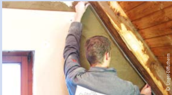
Kompriband einlegen für Anschluss an Sparren.
