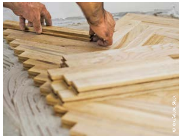
Verlegung von Stabparkett in Kleberbett
