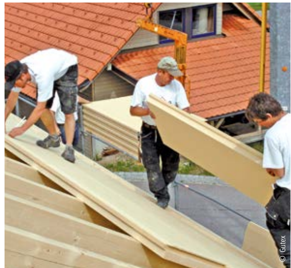
Wärmebrückenfreie Aufsparrendämmung mit wasserabweisenden Holzfaserdämmplatten
