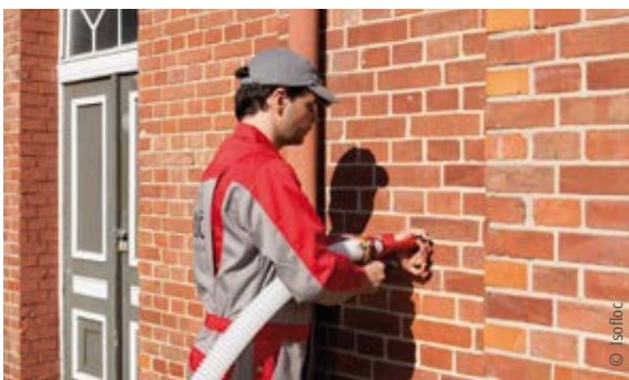
Nachträgliche Einblasdämmung bei zweischaligem Mauerwerk
