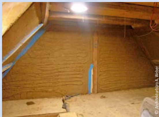
Einschlänmen der Heizrohre in Lehmgrundputz auf Schilfrohrplatten
