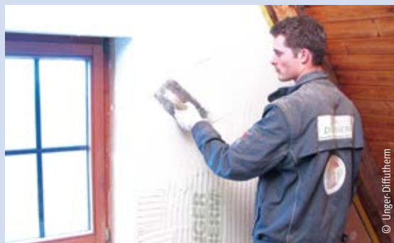
Armierungsgewebe in Kalk- oder Lehmputz einarbeiten.
