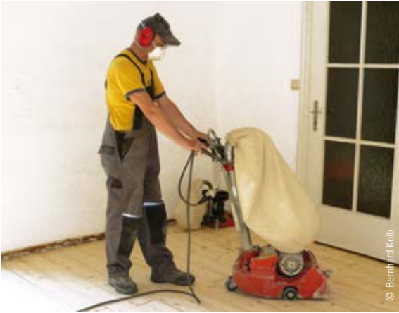
Der Autor beim Abschleifen eines Dielenbodens, der jahrzehntelang unter einem PVC-Boden begraben lag.
