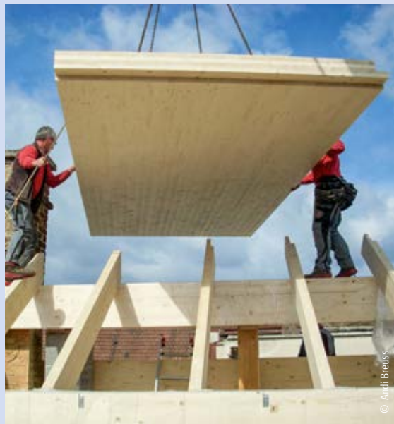
Holzbauteile vorgefertigt, dadurch deutliche Verkürzung der offenen Bauzeit
