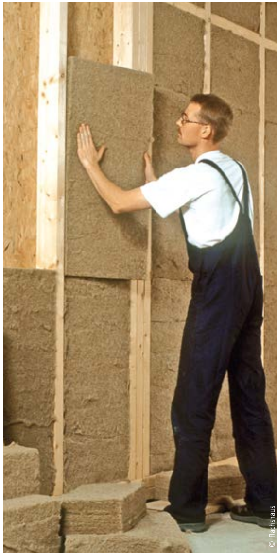
Ausfachung von Ständerwerk mit Flachsmatten
