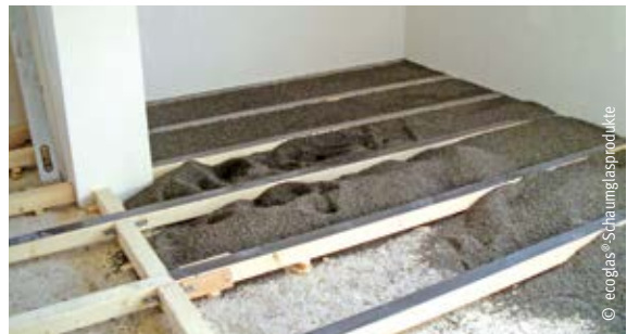
Auffüllen eines Hohlräumes mit Glasschaumschotter
