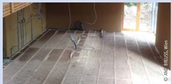
Lehmestrich mit integrierter Fußbodenheizung; Eichenboden verschraubt auf Lagerhölzern, eingebettet in Lehmestrich (anstelle von Klebparkett)
