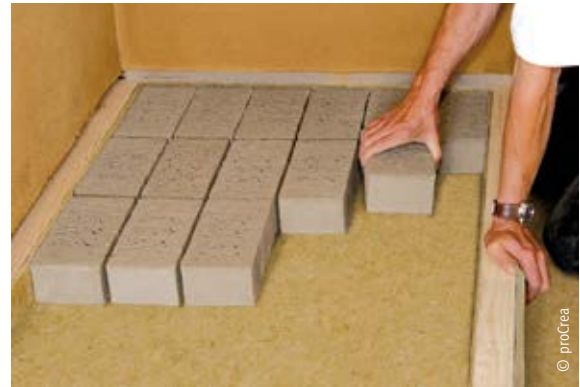
Einbau der Lehmsteine auf Hanffilzmatte (= schalltechnische Verbesserung)
