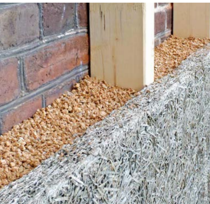
Außenwanddämmung: Korkeinschüttung mit Holzwolle-Dämmplatten auf Unterkonstruktion
