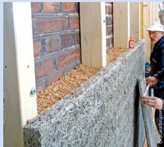
Vorhangfassade mit Heraklithplatte und Korkschtüttung. Abdichten der Fugen zwischen Mauerwerk und Tragsystem mit Hanf- oder Flachszipf wird empfohlen, um ein Hinterströmen der Konstruk- tion mit Kaltluft sicher auszuschließen.
