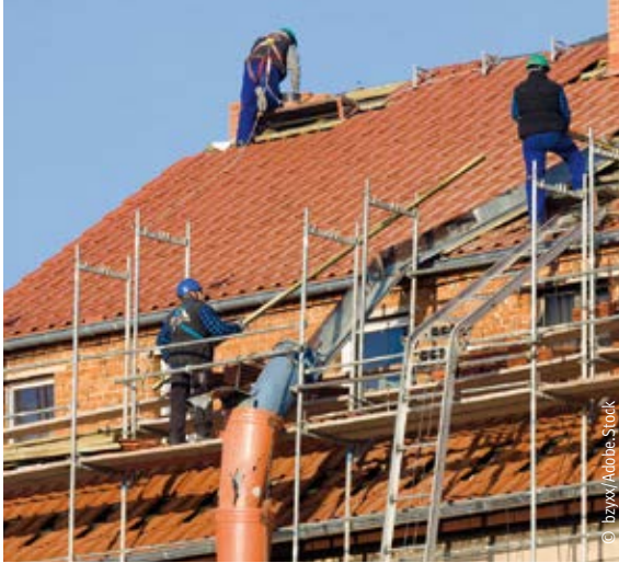
Dacheindeckung mit naturroten Falzziegeln
