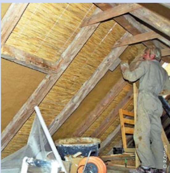
80 mm Schilfrohrplatten als Zwischensparrendämmung und Putzträger für Lehmputz (der zugleich als Brandschutz dient)
