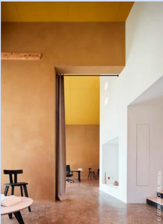
Fußboden aus gestampfter Erde, verfeinert zu „Lehmterrazzo“, Wände mit Lehmputz, Beplankung der Akustikdecken mit 9 mm Schafwollefilz.
