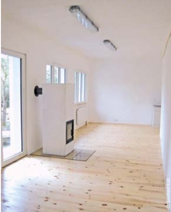
Kalk als Anstrichmittel wirkt geruchsbindend und trägt zur Verbesserung der Raumluft bei. Der ehemalige Lagerraum stand jahrelang leer. Durch den Anstrich mit reiner Kalkfarbe ließ sich der muffige Geruch dauerhaft beseitigen.
