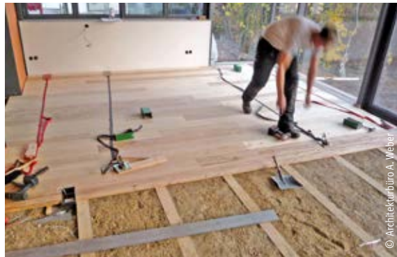
Ulmenmassivparkett auf Fußbodenheizung in Stampflehm
