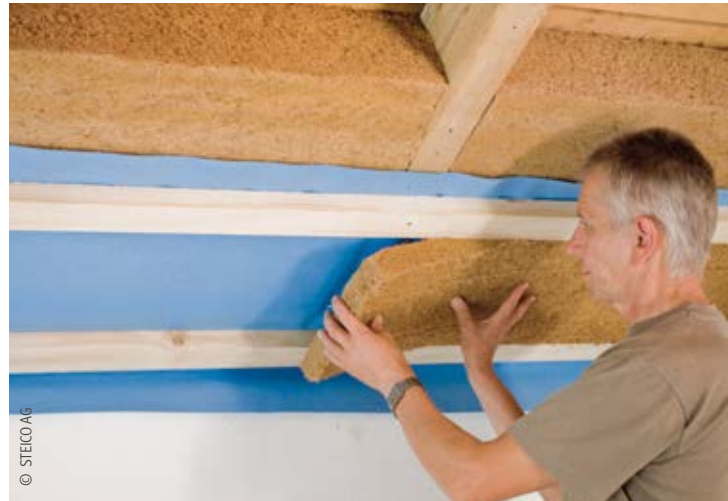
Ausfüllen der Installationsebene mit Holzfasermatten
