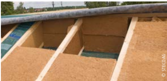
Einbau von oben mit klemmbaren Holzfasermatten
