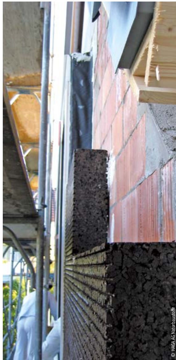
Korkdämmplatten als Fassadendämmung
