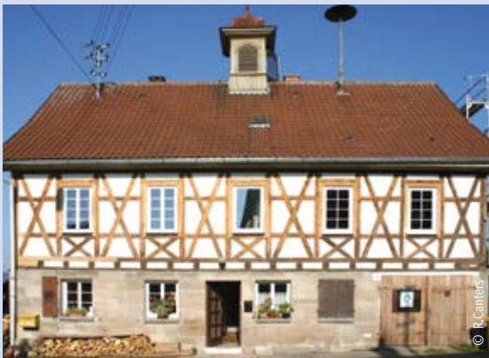
Aufsparrendämmung mit 120 mm Schilfrohrplatten
