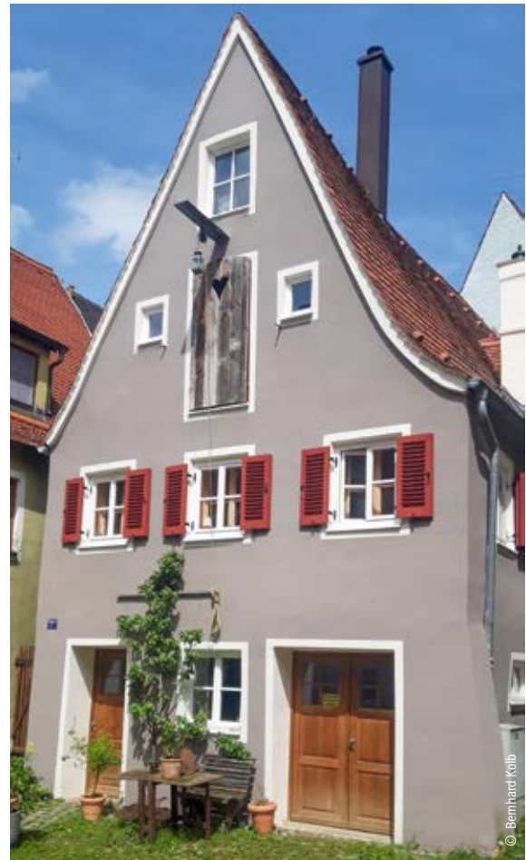
Fenster geben der Fassade ihr Gesicht. Das Verhältnis der Fenster zu den Wandflächen muss ausgewogen sein. Beim Altbau sollte sich insbesondere die Sprosseneinteilung der Fenster im Maßstab der Fassade wiederfinden.
