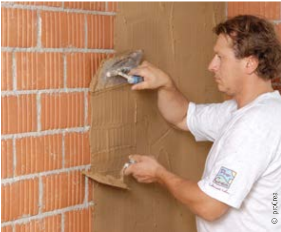
Auftrag des Grundputzes
