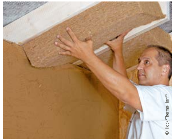
Dachdämmung mit Hanffasermatten
