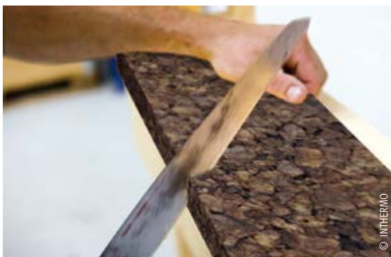
Einfacher Zuschnitt von Korkdämmplatten
