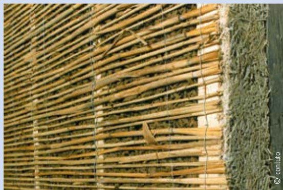
Innendämmung mit Wärmedämmlehm
