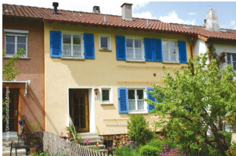
Reihenhaus in Tübingen, gedämmt mit verputzter Vorhangfassade und 16 cm Zellulose-Einblasdämmung. Beplankung mit Holz- wolle-Leichtbauplatten.
