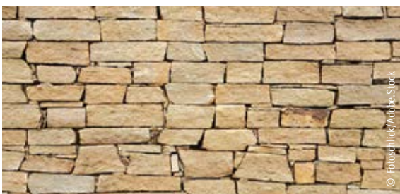
Bruchsteinwand, Steine trocken aufgesetzt
