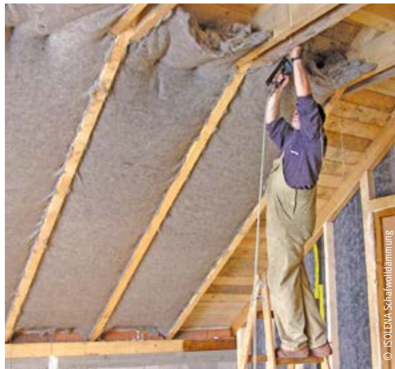
Dachdämmung mit Schafwollmatten
