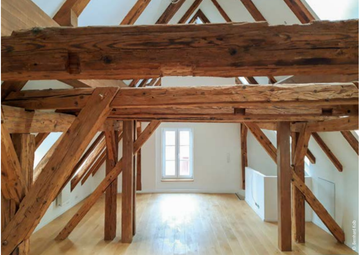
Ein Dachausbau schafft Platz im Haus.
