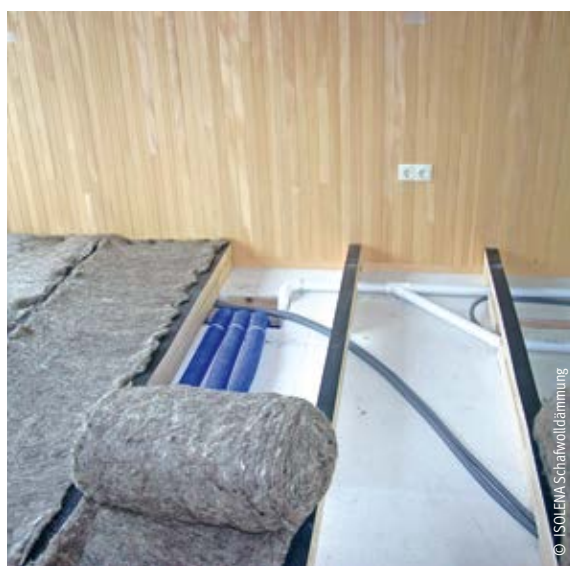
Fußbodendämmung mit Schafwollmatten
