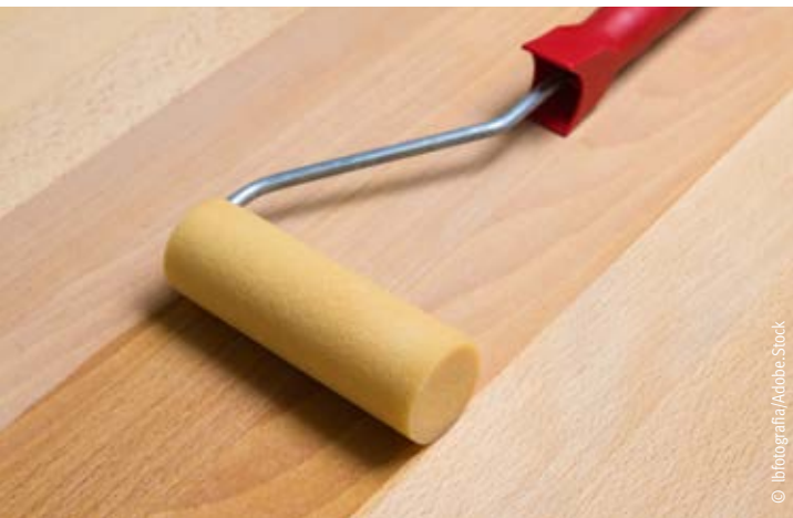
Auftrag von Fußbodenöl auf neuer Holzdielung
