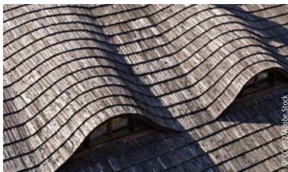
Historische Dachverkleidung mit Holzschindeln
