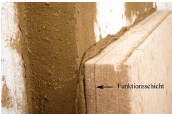
Befestigen der Holzfaserdämmplatte mit einem Lehm-Kleber. Deutlich erkennbar: integrierte Funktionsschicht im wandseitigen Drittel der Dämmplatte.
