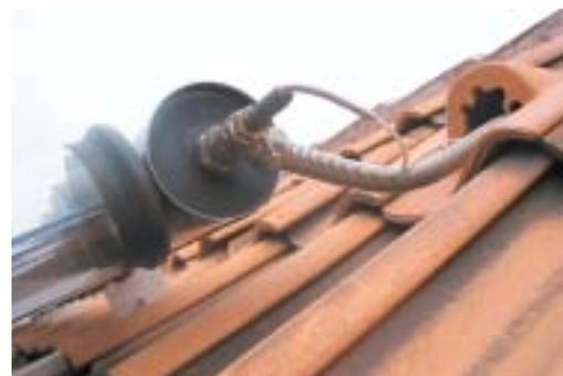
Mangelhaft: Ungedämmte Kollektoranschlussleitungen
