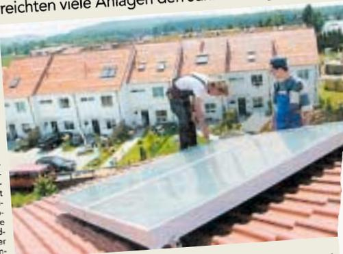
Fünf Quadratmeter Flachkollektoren genügen, um jährlich rund 65 Prozent des wassers für einen Vier-Personen-Haushalt zu erwärmen. Foto: ...
