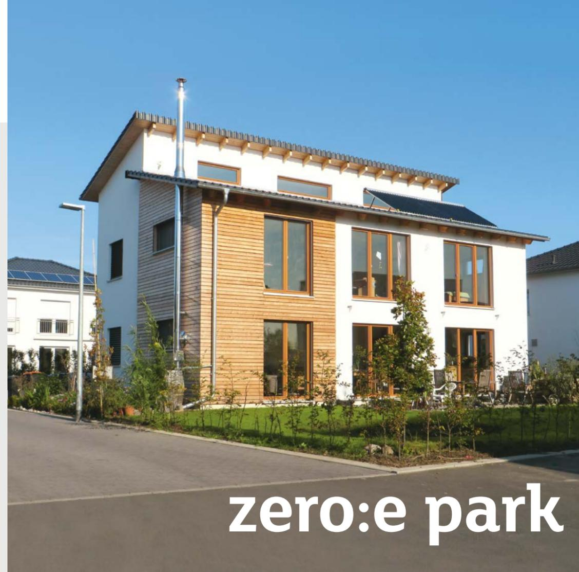
Die Südfassade eines Passivhauses im zero:e park. Auf dem Dach unterstützen Vakuum-Röhrenkollektoren die Holzheizung.
