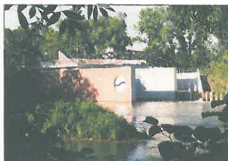
Wasserkraftwerk Herrenhausen (Station des Projekt-Parcours)
