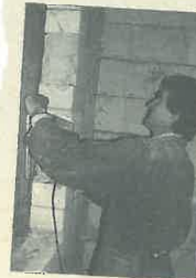
Hausbauer Gert Bühler ist mit letzten Feinarbeiten an der Dämmung beschäftigt.
