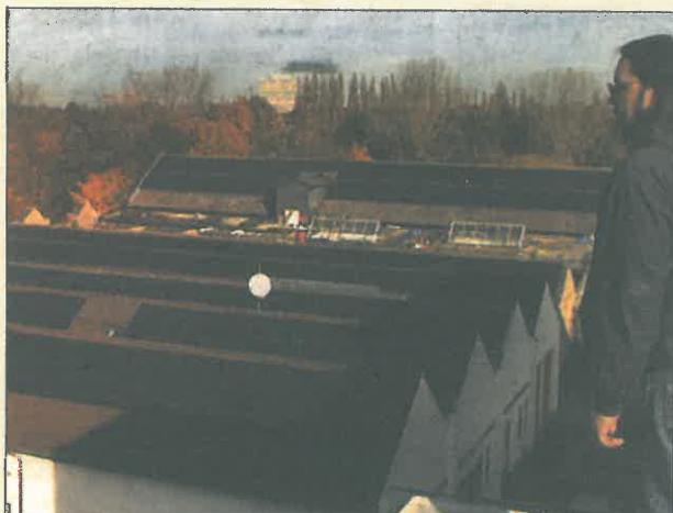
1160 Solarmodule auf und im Dach des Gewerbehofs sind gestern ans Netz gegangen. Plümer
