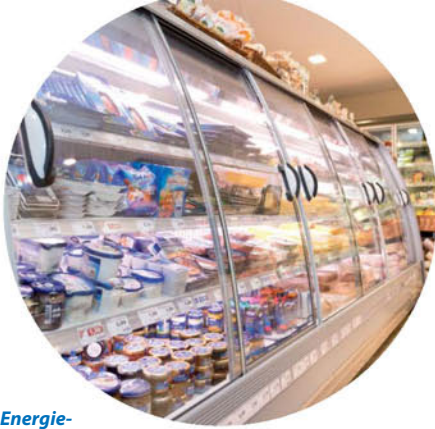
Energie-sparendes Kühlmöbel mit Anschluss an die Kältezentrale
